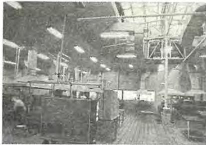
図 16. 35 三菱重工業(株)川崎自動車製作所厨房 FH-W 412 R, FLR-40×2 灯用防湿形ケイ光灯, GV-521 15 W 殺菌灯(壁), GH-521 15 W 殺菌灯(天井)
