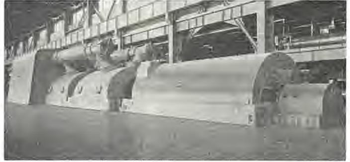
図 2.1 関西電力堺港発電所納め 300,000 kVA 内部冷却タービン発電機
