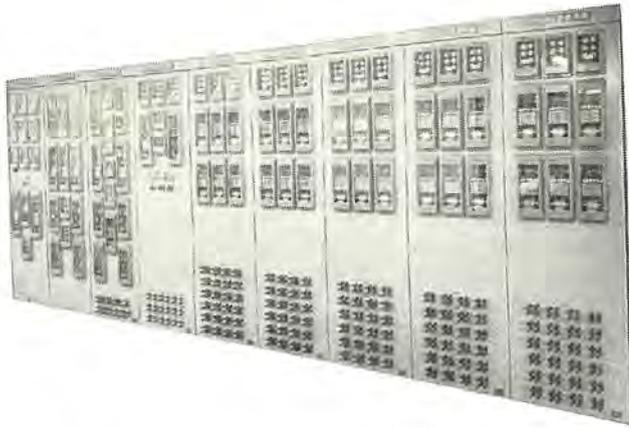
図 3.65 関西電力湖南変電所納め 275 kV 母線保護継電装置
