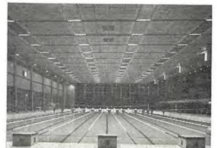
図 16.60(a) 広島県立屋内プール (広島市) パラウェッジルーパ使用ケイ光灯 40 W 1368 灯により水面の平均照度 1,000 lx を出している
