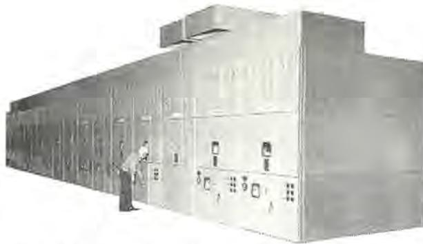
図 3.63 日本鋼管(株) 福山工場納め 23 kV 3,000 A 二重母線式特高キュービクル
