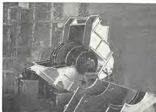
図 4.91 住友金属工業(小倉)向け焼結炉用主排風機
