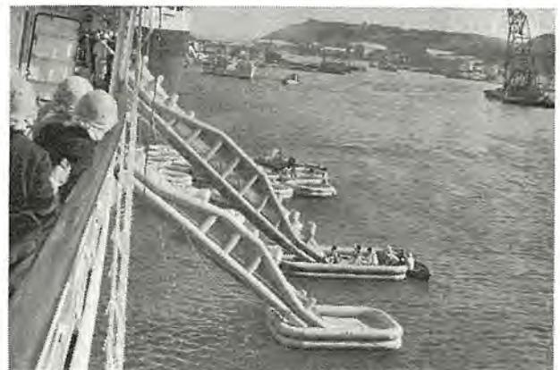
図 19.17 連絡船 (約8,000トン) に装置された14m および11m 膨張式すべり台
