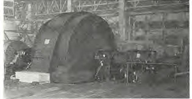
図 2.16 ペルー、パウカルタンボ 発電所納め 24,000 kVA 横軸水車発電機
