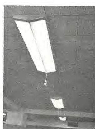
図 16. 24 永田町ビル FA-FP 形 60 W 2 灯用高照度ケイ光灯器具（プラスチックカバーの着脱自在）
