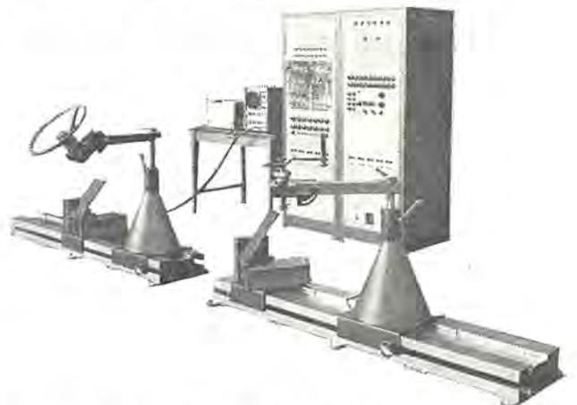
図 12.18 人間工学研究用制御動作解析装置
