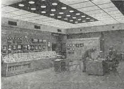
図 16. 38 中国電力(株)岩国火力発電所制御室 (FLR-40×102 灯+FCL-30×24 灯) 光天井ダウンライト制御盤用 700~800 lx, 机上面 600×700 lx
