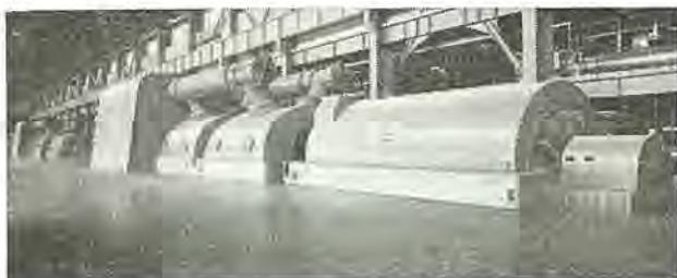
図 1.2 内部冷却タービン発電機
