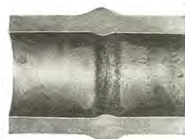
図 3.9 圧接部写真 Fig. 3.9 Photo of welded pipe.
