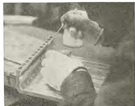
図 3.10 \square ウ材塗布 Fig. 3.10 Application of filler metal.
