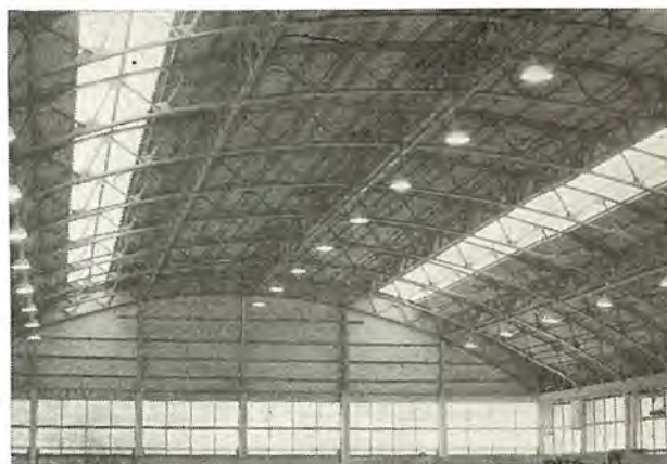
図 1.3 ケイ光水銀灯 HF-400 反射 ガサ 付照明器具による高天井工場の照明
