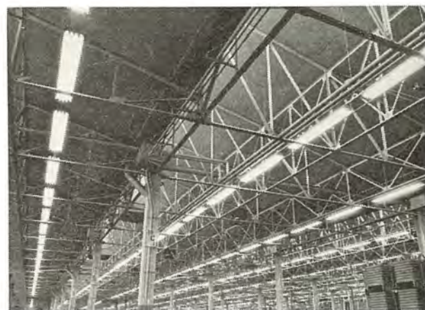
図 1.2 高出ケイ光灯 FLR-110 HW 3 灯用反射 ガサ 付照明器具による中天井工場の照明
