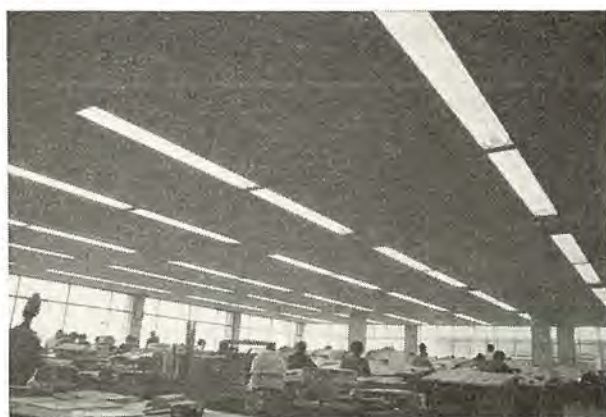
図 1.1 埋込形高出力ケイ光灯 FLR-110 HW×2 灯用器具による設計室の照明
