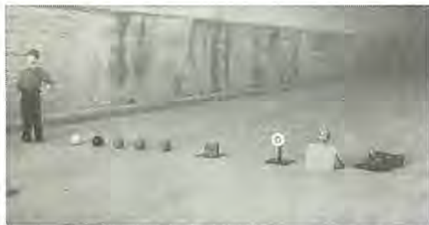
図 4.17 使用した各種視標 (左から白, 黒, 灰, 緑, 赤の各球, タコ形, ランドルト氏環の順, 右端は照度計) Fig. 4.17 Various visual targets used.
