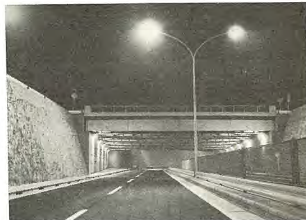
図 1.4 銀白色ケイ光水銀灯 HF-400 SW×2 灯用道路照明器具による高速道路の照明
