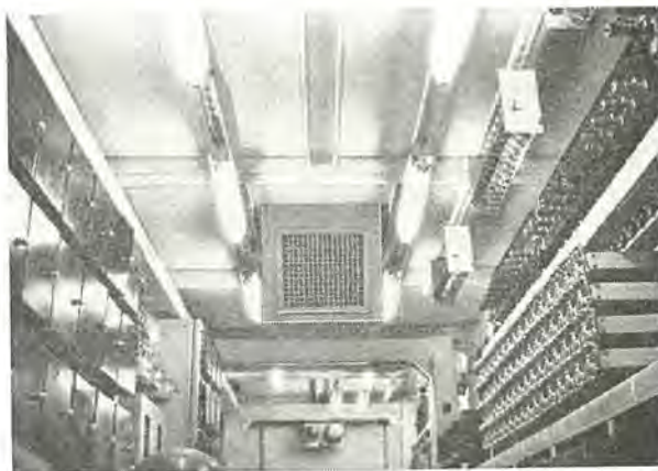
図 3.2 計器板内部の三方吹出口 Fig. 3.2 3-way discharge grill behind panel board.
