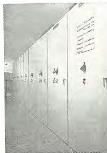
図 7.4 自動プリセット装置(八幡、戸畑) 各自動位置制御盤 Fig. 7.4 Automatic preset device each automatic position control panel.
