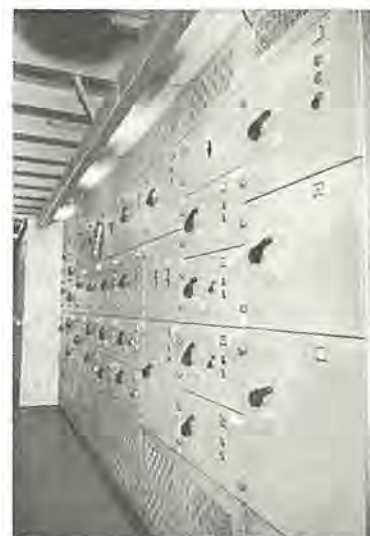
図 5.5 両面形集合起動器 Fig. 5.5 Type D group starter panel.
