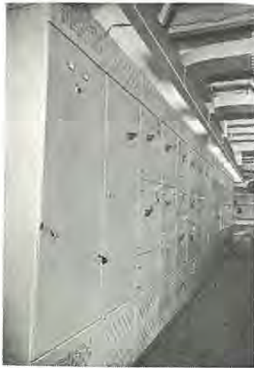
図 5.6 両面形集合起動器 Fig. 5.6 Type D group starter panel.
