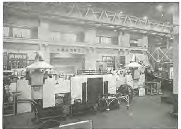
1.5t 低周波誘導炉および連鑄設備
