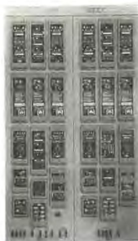
図 2.1 三菱 バランスリレー 盤面図例 (第 1 形式の場合の例) Fig. 2.1 Front view of Mitsubishi balance relay panel (Type I).
