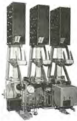
12kV 750MVA 3,000A C形空気シュ断器
