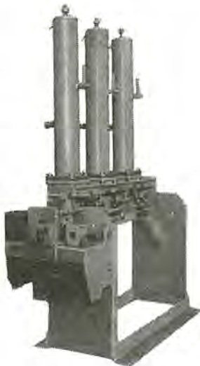
図 5.11 10-ML-25 形少油量油シヤ断器 Fig. 5.11 Type 10-ML-25 low oil circuit breaker.
