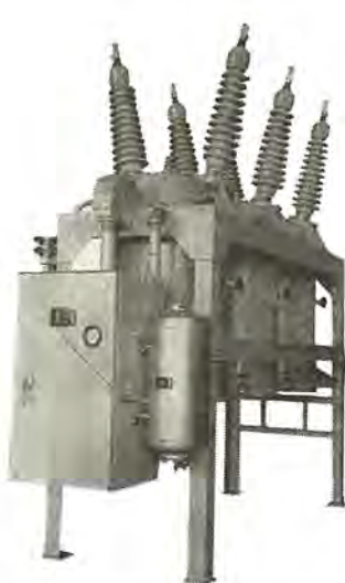
図 5.7 70-GTE-250 形油シヤ断器 Fig. 5.7 Type 70-GTE-250 oil circuit breaker.
