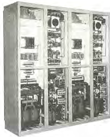
図 3.8 サイリスタレオナード裏面 Fig. 3.8 Rear view of thyristor leonard cubicle.
