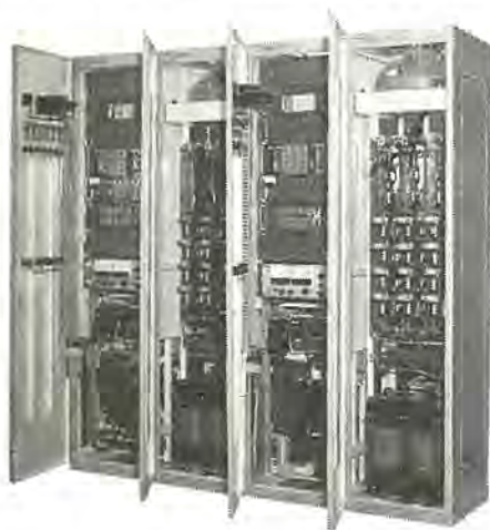
図 1.1 サイリスタレオナード装置 Fig. 1.1 Front view of thyristor leonard cubicle.
