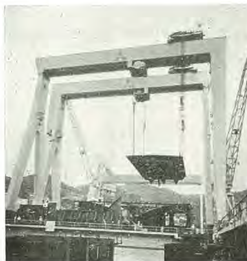
図 2.2 300t ゴライアスクレーンの外観図 Fig. 2.2 300t goliath crane.
