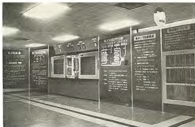
図 10-23 熱ポンプ装置全景 Full view of heat pum parrengement.
