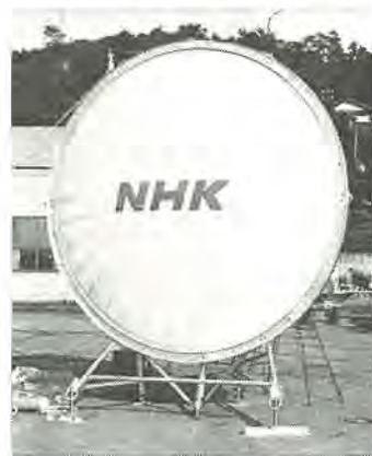
図 11-21 組立完了した 3 mφ 気球 アンテナ Completed erection of 3 mφ balloon antenna.
