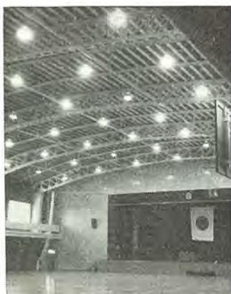
⑫ 大阪市立住吉商高体育館 デラックスケイ光灯水銀灯 300 W 58 灯ほか 70 灯 計 128 灯
