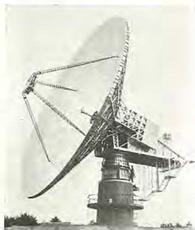
図 11-53 宇宙通信用送受信アンテナ 20 m diameter space communication antenna.
