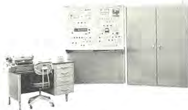
(左よりプログラム機、プログラム制御盤、操作盤) 図 12-25 国鉄浜松工場納め ATC 自動試験装置 ATC automatic test equipment for J. N. R..
