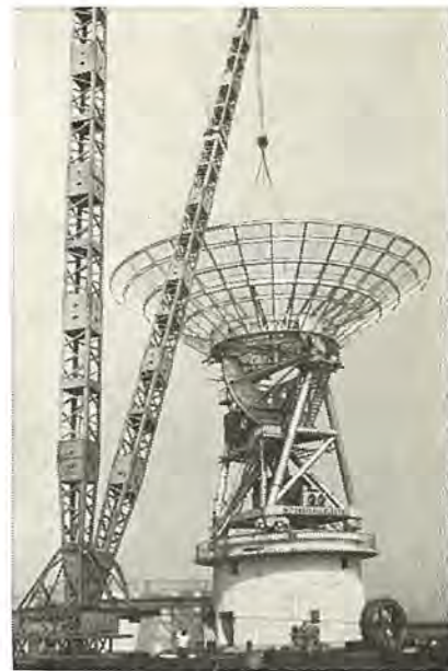
左側はアンテナつり上げ組立中のガイデリック（Guy Derrick）
