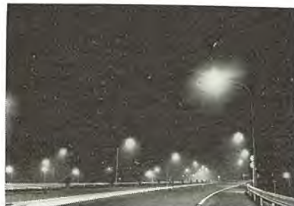
① 名神高速道路小牧 インターチェンジ HP-314 ランプ HF-450X×69 灯 計 74 灯 250×5 灯 平均照度 18.3lx
