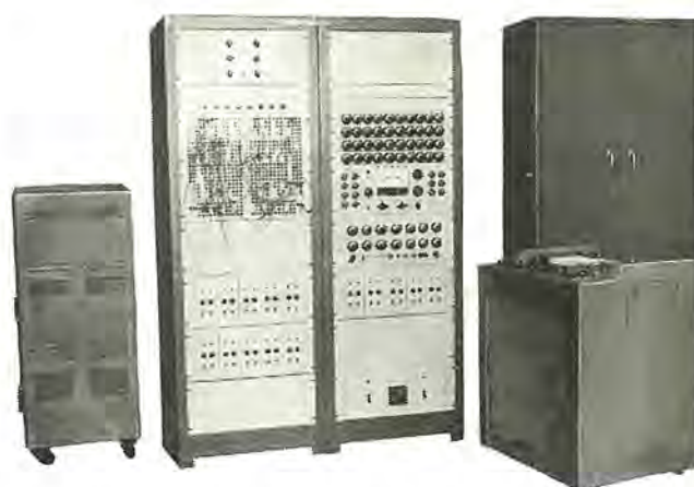
図 12-12 MELCOM EA-7305 低速度 アナログ 計算機 MELCOM EA-7305 low-speed type analog computer.
