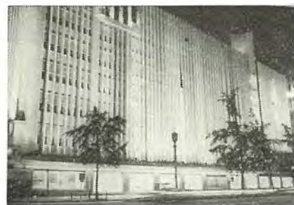
㉑ 十合百貨店 壁面照明(大阪) タリウム水銀ランプ H-400L×21灯 計29灯 H-300L×3灯, HRF-300L×5灯 水銀ランプ700Wなど 30灯
