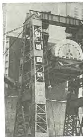
図 1-3 ホールアップ中の 257,000 kVA タービン発電機固定子 Stator of 257,000 kVA inner-cooled turbine generator under erection.
