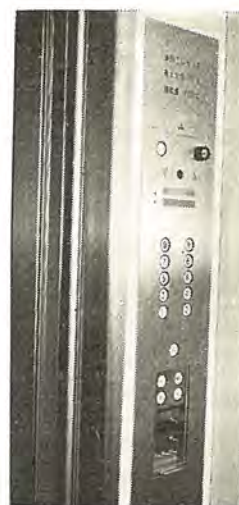
図 9-7 リセスボタンの カゴ操作盤 Car operating panel with recess buttons.
