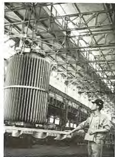
図 11-33 無線操縦によるクレーン作業 Wireless crane controller in operation.
