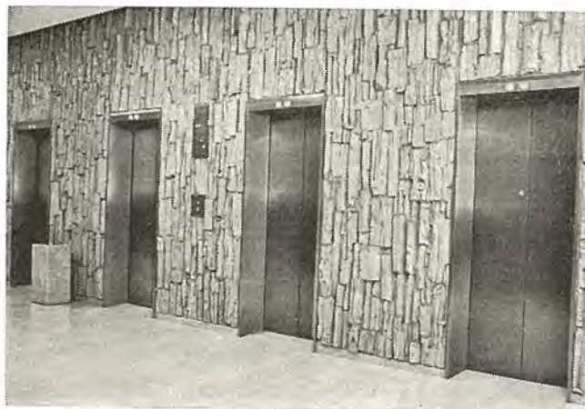
図 9-5 御堂ビルのエレベータおよび乗場 Elevator entrance of the Midō building.
