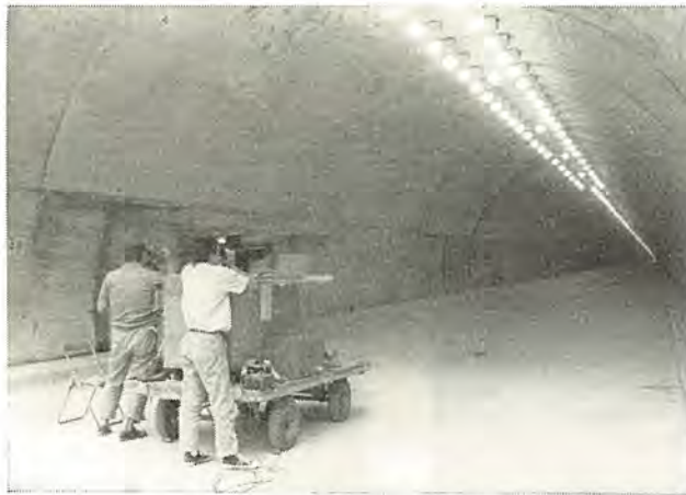
図 15-16 トンネル 内照明 試験 Lighting test in tunnel.
