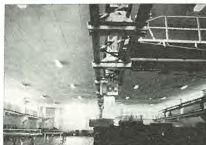
⑬ 大洋漁業福岡冷凍工場製氷室 FH-W 402 R 40 W×2 約 120 lx
