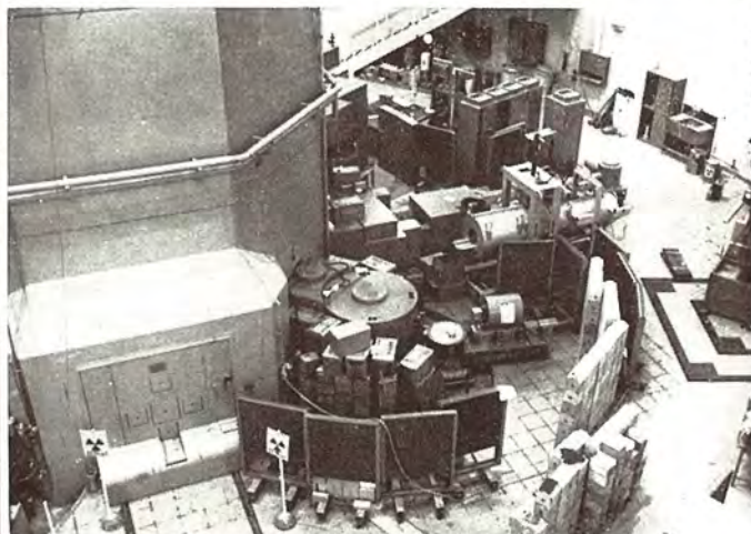
京都大学原子炉の北側に据え付けられた 中性子モノクロ用チョッパと中性子モノクロメータ Monochromatic neutron chopper (far side) and neutron monochrome- ter (near side) installed in north side of Kyōto University Reactor.
