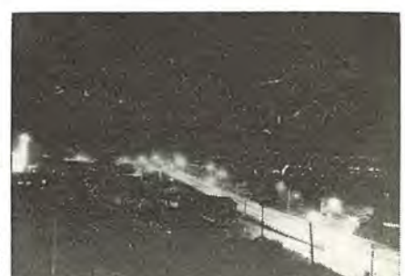
③ 国鉄阪和線 金岡跨線橋 高出力タリウム水銀ランプ H-400 L 12 灯 のほか HF-100×14 灯 計 26 灯
