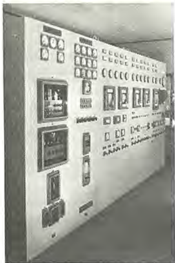
図 1-11 日本 カーバイド 魚津工場納め ブラシレス 発電機用中央制御盤 Central control board for brushless generator, Uozu Nippon carbide Co.
