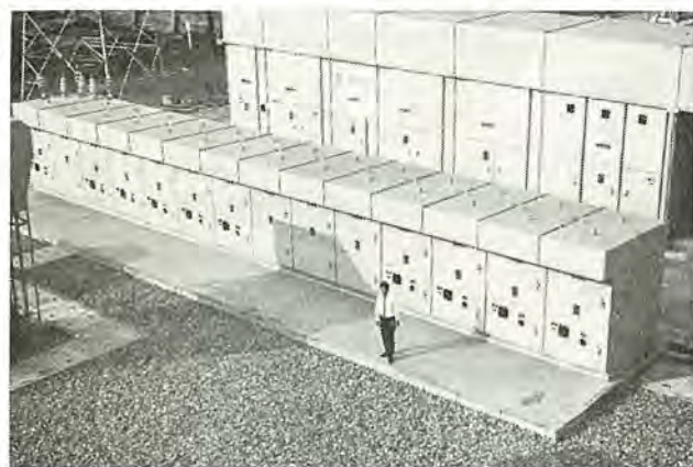
図 2-58 80.5/23kV 800A 屋外用キュービクル全景 (手前が 23kV 用、後が 80.5kV 用) Full view of 80.5/23kV 800A outdoor cubicles.
