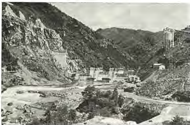
図 8-7 電源開発七色発電所 View of Nanairo Power Station.
