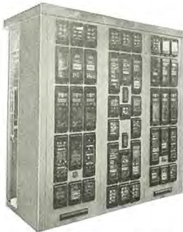
図 2-73 関西電力加古川変電所納め PC-338 形搬送継電装置 Type PC-338 carrier relaying scheme.
