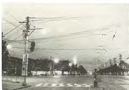
④ 国道一号線京都市大石橋交差点 HF-400 L×4 灯 ポール高さ 7 m 約 20lx
