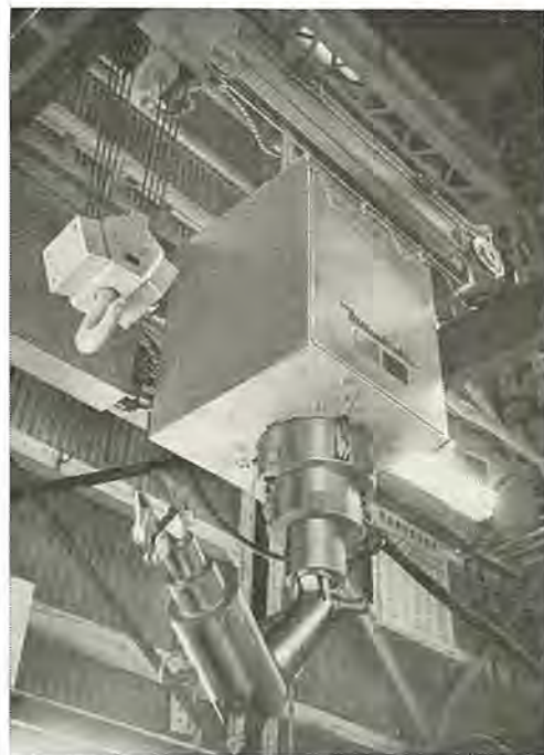
インドに輸出された パワ・マニピュレータ Power manipulator exported to Atomic Energy Establishment in India.
