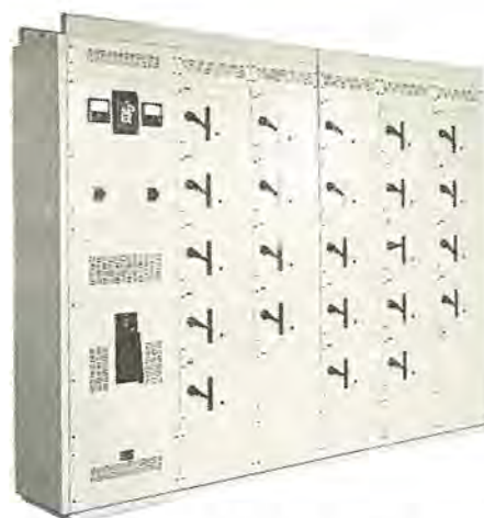
図 1-9 呉羽紡績教賀工場納め コントロールセンタ Type NC-23BS control center.
