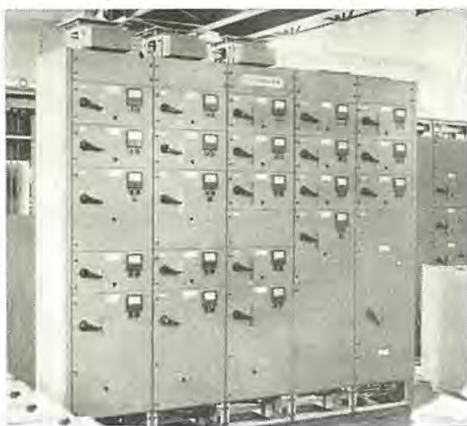
図 4-82 大阪 ガス 倉庫工場向け NC-23BS 形 コントロールセンタ Type NC-23BS control center.
