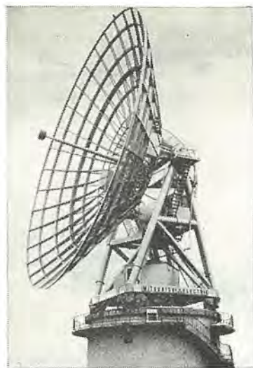
図 11-55 超遠距離 レーダ 用空中線 25 meter experimental antenna for long range radar and radio physics research.
