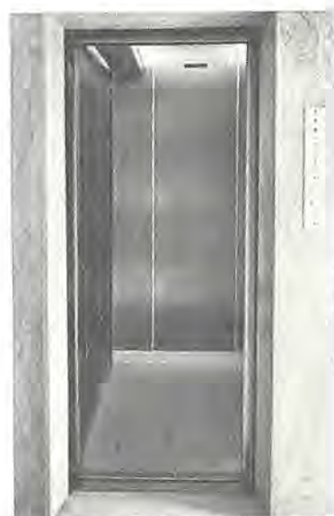
図 3.1 アパート用エレベータ Fig. 3.1 Apartment elevator.
