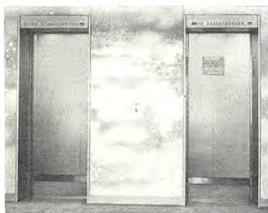
図 5.7 三方ウツ幕板に彫り込んだ乗場位置表示文字 Fig. 5.7 Elevator entrance at Nagoya Kokusai Hotel
