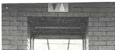
図 5.5 ASP式を採用の場合の ホールランタン 標準形 Fig. 5.5 Elevator entrance.
