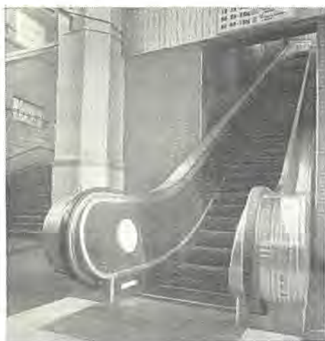
図 2 国鉄秋葉原駅に据え付けられた 1200 DH 2 -P 形三菱エスカレータ
