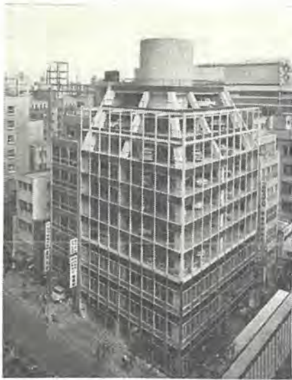
図 4.6 中川ビル駐車場全景 Fig. 4.6 Vertically arranged parking places, Nakagawa Bldg.
