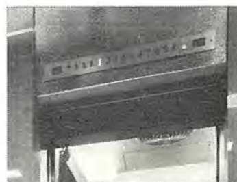
図 5.6 三方ウツ幕板に埋込みのフ ェースプレート 付乗場位置表示盤 Fig. 5.6 Hall position indicator mounted on transom panel.
