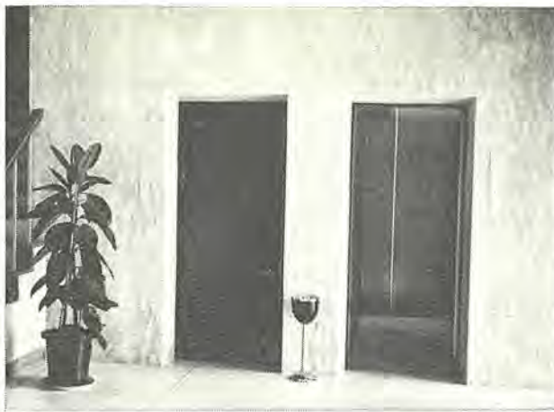
図 3.2 アパート用エレベータの乗場 Fig. 3.2 Corridor of apartment elevators.
