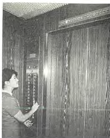
図 5.3 エレベータのカゴ室内部 Fig. 5.3 Car operating panel at Hotel New Ōtani.
