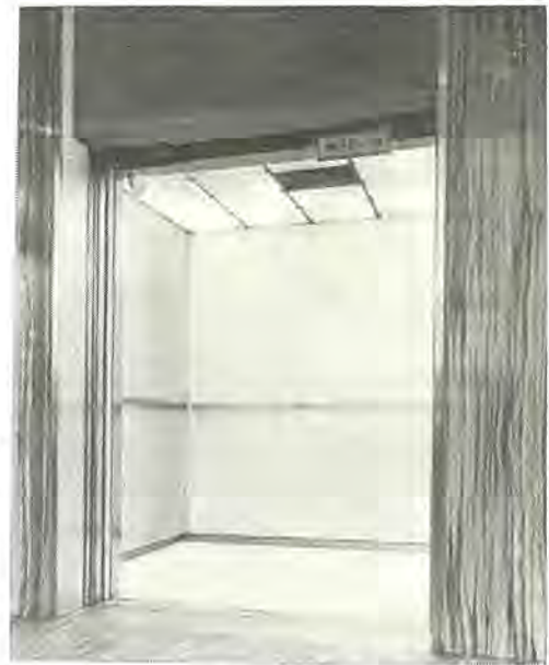
図 5.4 手すりを設けたカゴ室 Fig. 5.4 Cab with handrail.
