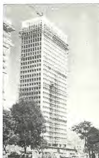
三菱エレベータを設置するパバリア本社ビルを北側大通りから望む。左端にアパート(Cブロック)がわずかに見える。
