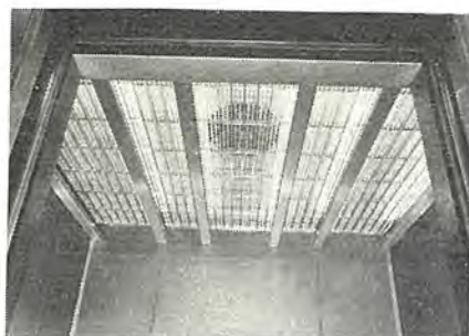
図 5.1 エレベータのカゴ室内の照明 Fig. 5.1 Car lighting at Hilton Hotel.
