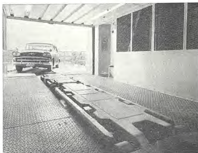
図 5.10 大手町建物田村町ビル駐車場屋上階出庫動作 Fig. 5.10 Roof parking place of Tamurachō Bl'dg.
