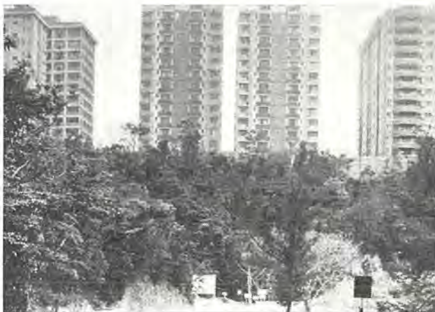
図 2.8 高級アパート建物 香港 レパルス ベイ アパート 三菱エレベータ設置 Fig. 2.8 Repulse Bay apartment where Mitsubishi elevator installed.
