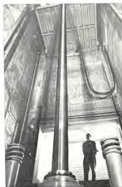
図 2.4 油圧エレベータ Fig. 2.4 Hydraulic elevator.
