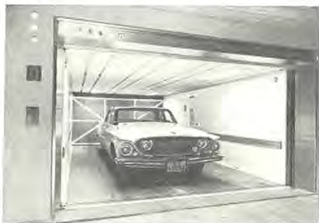
図 1.1 乗用自動車用エレベータ Fig. 1.1 Elevator for motor cars.
