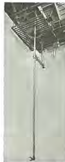
図 3.5 線源組立装置 Fig. 3.5 Under-water manipulator.
