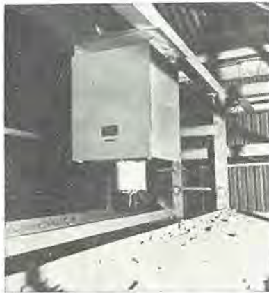
図 4.2 原料通過検出装置の検出器 取付状況
