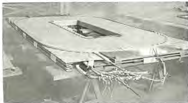
図 3.6 コイル押え板取付状況 Fig. 3.6 View of the vertical coil support.
