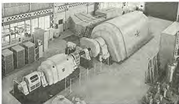
図 5.1 短 絡 発 電 機 Fig. 5.1 General view of short-circuit generator.
