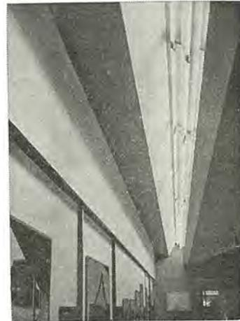
図 4.4 展示室天井埋込の高出力ケイ光灯 (FLR-110H-WDL×3 灯連続取付による壁面照明, 平均照度 350 lx)
