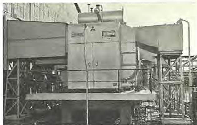
図 3.5 レクチフォームの設置と電解工場への接続状況 Fig. 3.5 Rectifier installation and its outside connections.
