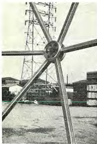
図 4.8 ジョイント部 Fig. 4.8 Hub joint.
