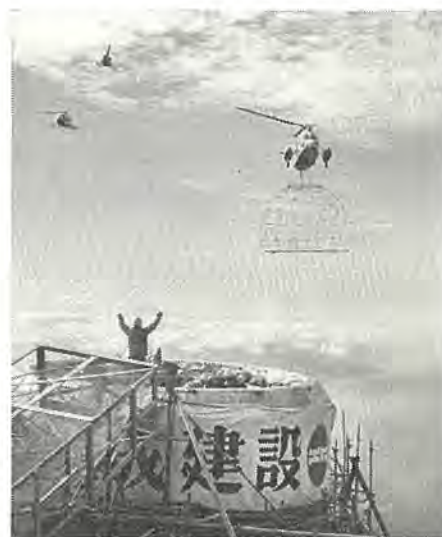
図 2.1 ヘリコプタによるレードームフレームの輸送状況 Fig. 2.1 Transportation of Radome frame by means of helicopter.
