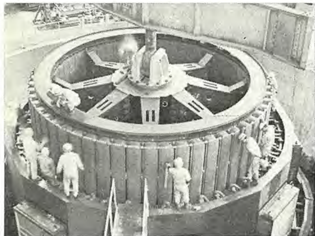
図 3.2 回転子のつり込み作業 Fig. 3.2 Lowering of the rotor.
