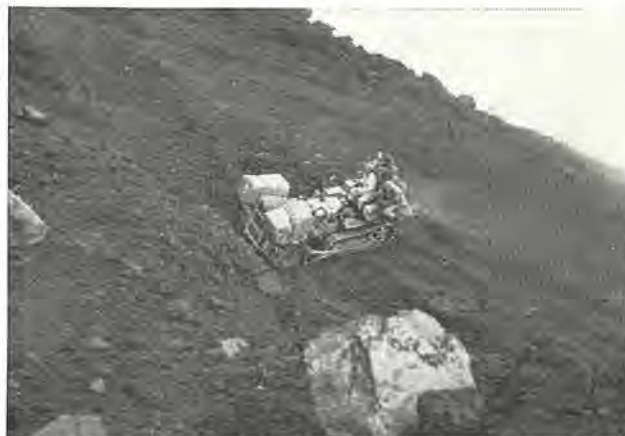
図 2.2 ブルドーザによる輸送状況 Fig. 2.2 Transportation by means of a bulldozer.
