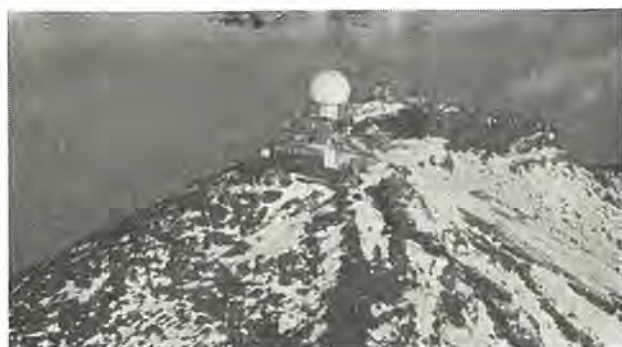
図 1.1 富士山頂レードーム Fig. 1.1 M. S. F. Radome on the top of Mt. Fuji.
