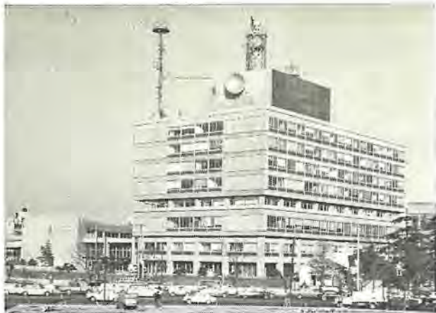
図 2.3 富士山気象レーダ東京局（気象庁） Fig. 2.3 Tokyo observation center in Japan Meteorological Agency.
