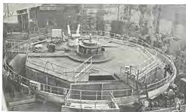
図 1.1 工場試験中の発電機 Fig. 1.1 Generator in the factory test.
