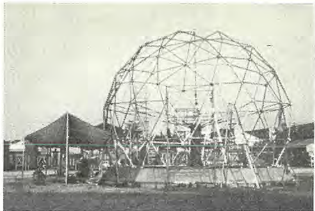
図 4.10 実物レードーム荷重試験 Fig. 4.10 Loading test of the radome.
