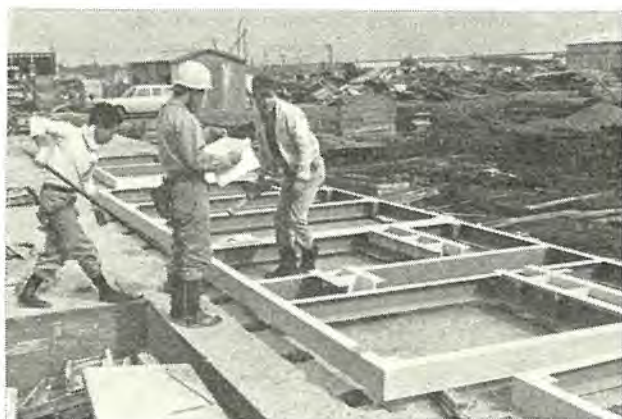
図4.1 基礎ベースレベル調整中 Fig. 4.1 Channel bases in level adjusting.
