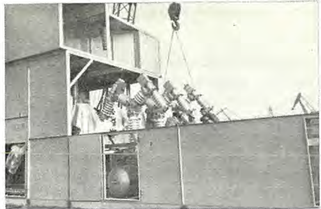
図 4.6 シヤ断器組立中 Fig. 4.6 Abb in assembling.
