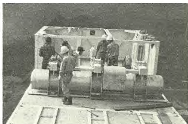
図4.3 基礎ベース上にシヤ断器補助タンク取付中 Fig. 4.3 Abb aux. tank on the channel base.
