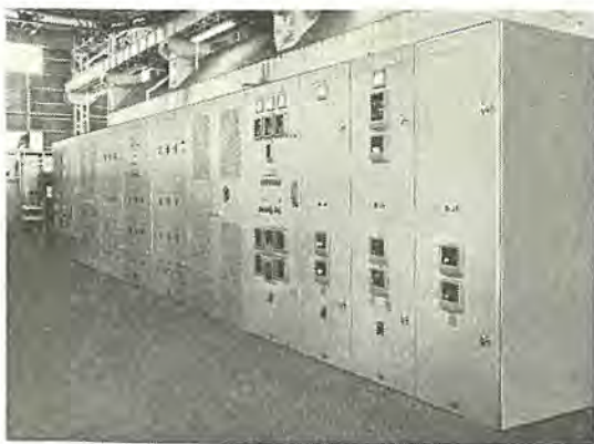
図 4.2 3.3kV キュービクル Fig. 4.2 3.3kV cubicles.
