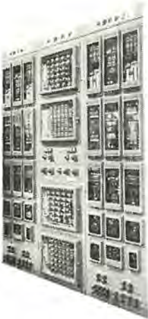
図 2.5 搬送保護継電装置 正面図 Fig. 2.5 Front view of carrier protective relay panel.
