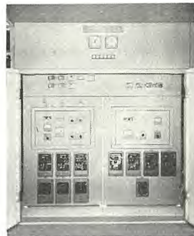
図 6.4 調速機制御盤 Fig. 6.4 Governor control panel.
