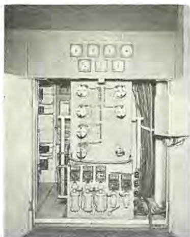
図 9.1 水車制御盤 Fig. 9.1 Water turbine control cabinet.
