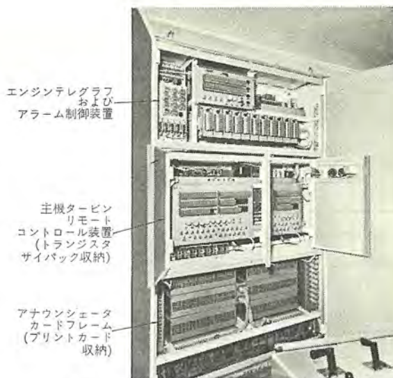
図 9.2 リレー 制御 盤 Fig. 9.2 Relay control panel.
