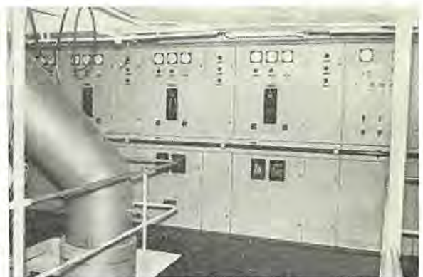
図 2.3 発電機室の主配電盤 Fig. 2.3 Main switchboard of generator room.
