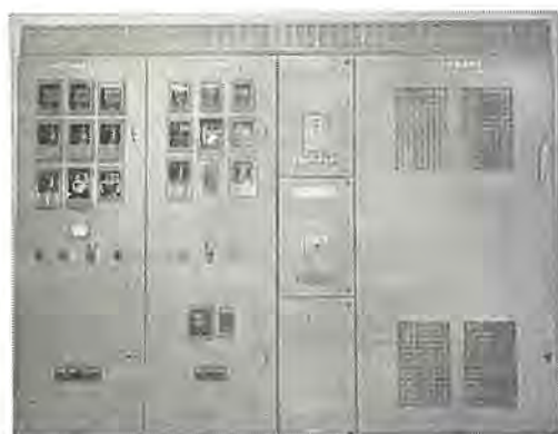
図 5.4 AVR キュービクル Fig. 5.4 Excitation cubicle.
