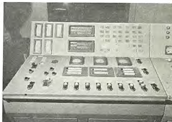
図 9.3 補機 コントロールコンソール 盤 (トランジスタ 式 多点温度計装備状態を示す) Fig. 9.3 Auxiliary control console panel.
