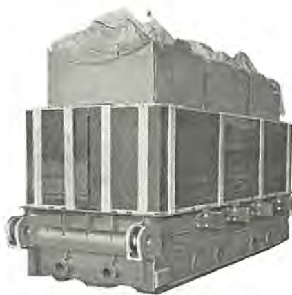
図 5.4 外鉄形鉄心 (120 MVA, 3φ)
