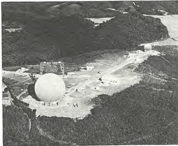
図 1.1 国際電々茨城宇宙通信実験所全景 Fig. 1.1 A bird's eye view of Ibaraki space communication center of KDD.
