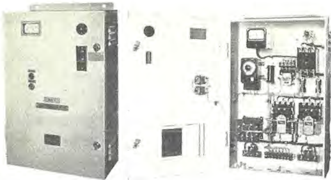
(a) 外観 (b) 内部 図 4.22 PX-309 形用起動器 Fig. 4.22 Type D starter.
