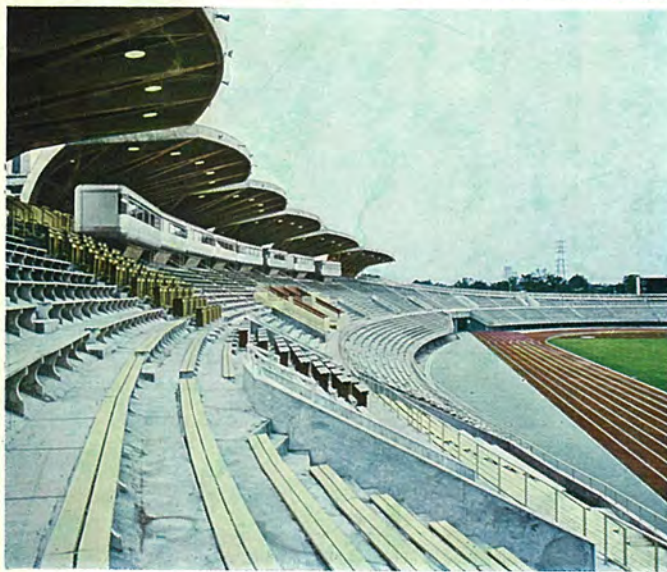
駒沢陸上競技場の照明
