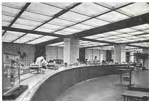
図 11.10 三菱銀行日本橋支店 光天井方式 平均照度 600~700 lx Fig. 11.10 Luminous ceiling of Mitsubishi bank Nihonbashi Branch.
