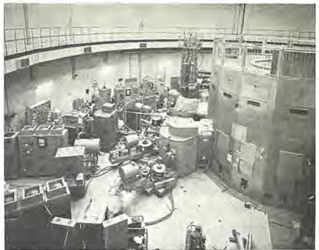
図 13.9 JRR-2 原子炉に据え付けられた3台の中性子回折装置
