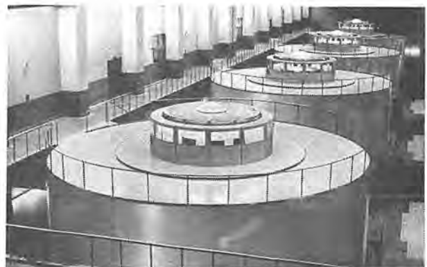
図 1.3 105,000 kVA 167 rpm 水車発電機 Fig. 1.3 Water wheel generator.
