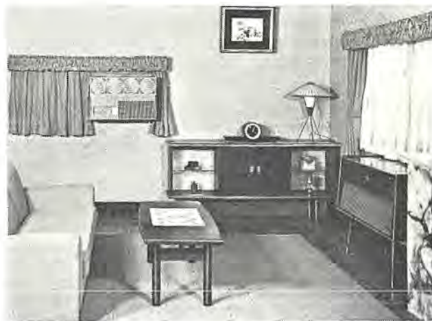
図 9.6 RD 形 ルームクーラー (据付例)
