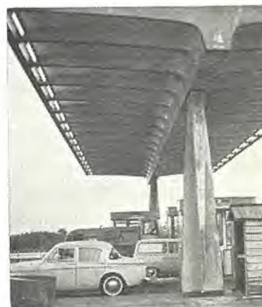
図 11.13 名神高速道路京都インターチェンジ入口料金所
