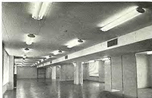
図 7.5 赤坂 プレスセンタ (ケイ 光灯 40 W×2 灯用 じか 付照明器具) Fig. 7.5 Akasaka press center.
