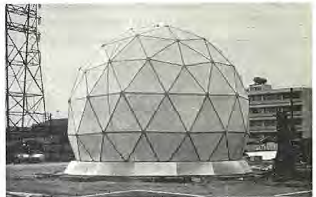
図 7.12 富士山頂観測所レードーム Fig. 7.12 Radome at mount Fuji observatory.
