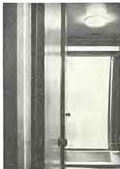
図 9.28 FCP-W-231 形 円形 20 W 防湿形器具 Fig. 9.28 Type FCP-W-231 round 20 W moisture proof lighting fixture.
