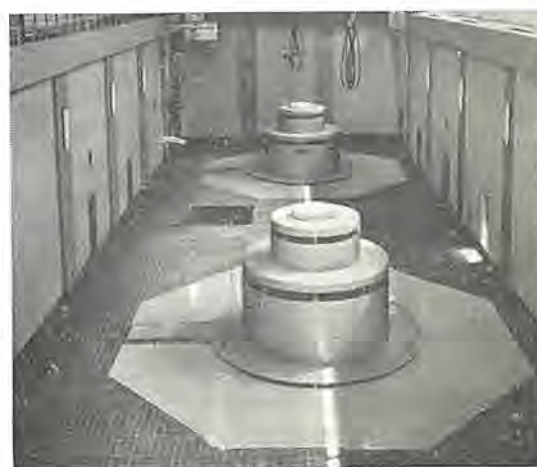
図 1.5 55,000 kVA 180 rpm デリヤ水車発電機 Fig. 1.5 Deriaz water wheel generator.
