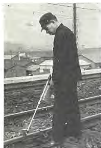
図 5.14 CM-2 形トランジスタ化クラックメータ Fig. 5.14 CM-2 Transistorized crackmeter.
