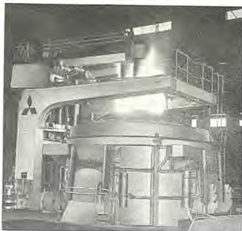
図 2.66 操業中の 30t アーク 炉 Fig. 2.66 30t arc furnace.
