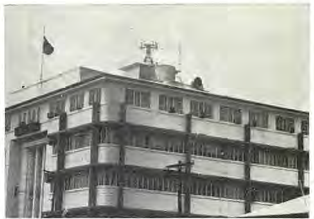
図 5.11 マニラ港にあるフィリピン気象庁屋上に据え付けられた気象レーダ
