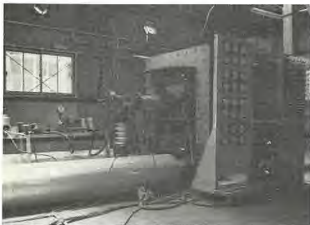
図 14.1 MHD 発電実験設備
