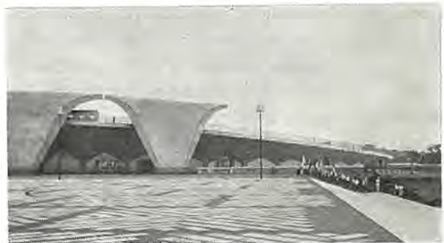
図 7.2 駒沢競技場 (外部より見たところ)
