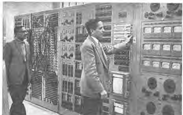
図 5.6 現地で据付調整当時の交流計算盤(空調されている)
