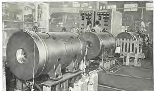
図 9.3 試験中の高周波発電機 Fig. 9.3 High frequency generators in testing.
