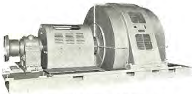
図 7.1 誘導同期電動機 2,200 kW 3,300 V 60 c/s 10 極 Fig. 7.1 Induction synchronous motor.
