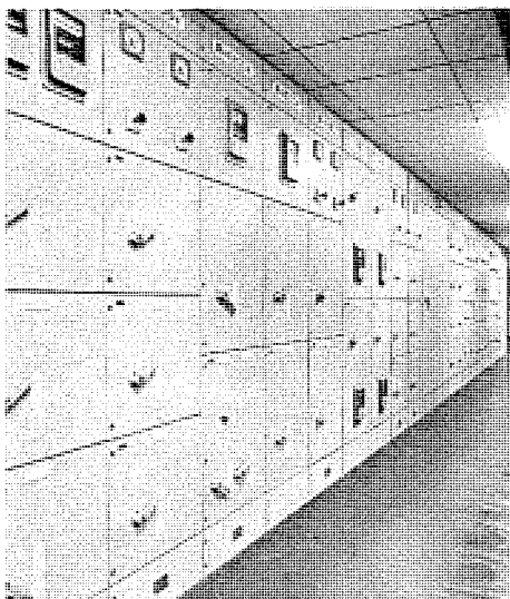
図 2.1 電気室に据え付けた コントロールセンタ
