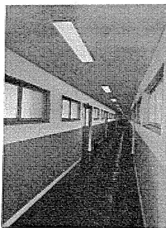
天井埋込形 FL-40 \times 1 灯 図 5.4 三菱電機商品研究所廊下 Fig. 5.4 Mitsubishi Electric Corp. consumer products engineering laboratory corridor.
