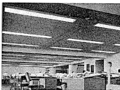
高出力ケイ光灯 110 W \times 2 灯埋込形 平均照度 700 lx 図 5.5 竹中工務店東京支店設計室 Fig. 5.5 Takenaka Engineering office, Tokyo branch design room.
