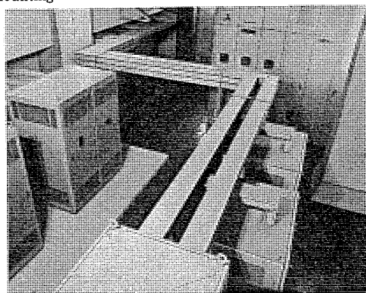
図 3.13 ビル 電気室のバスダクト 工事例 Fig. 3.13 Example of bus duct work in an electrical room of building.
