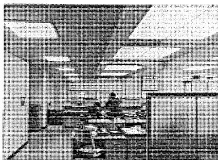
FY 形アクリライトカバー 埋込形 FL-40 W \times 10 灯 10 セット 机上 1,000~800 lx 図 5.7 三菱銀行虎の門支店 Fig. 5.7 Mitsubishi Bank Toranomon branch.
