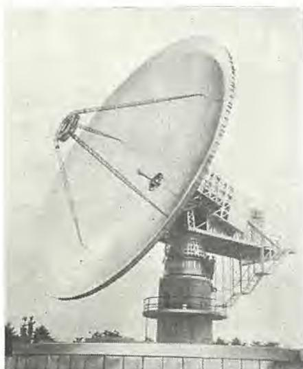
図 2 レードームで覆う前の送受信 アンテナ
