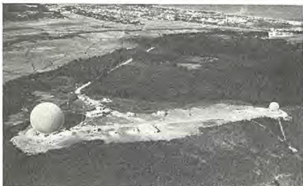
左側の大きな球形のものが 20 m 送受信アンテナを取めた 30 m レードーム、右側の小形レードームは追尾装置、中央建物が管制室で、この中に制御計算機、管制車などがある。
