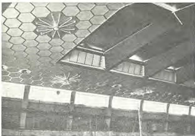
図 10-35 リンク 天井照明と電動開閉屋根 Rink ceiling illumination and motor operated roof.
