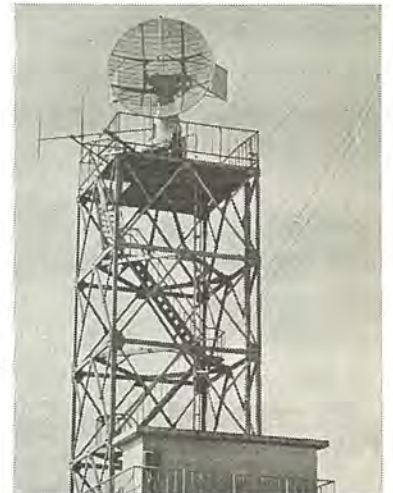
図 11-40 札幌管区気象台に設置された気象用レーダ (RC-4 C 形) Weather radar (type RC-4 C) installed at Sapporo meteorological observatory.
