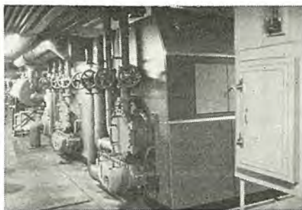
図 10-30 CT-100 形 チリングユニット Type CT-100 chilling unit.
