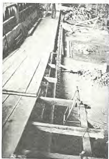
図 10-36 ブラインヘッダーの一部 Part of brine header.
