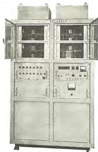
図 20-27 事故記録 オシロ 装置 Fault recorder.
