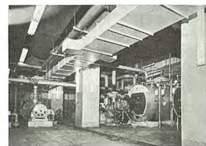
㉑西川ビル 機械室 (東京) (柱部分) 40 W 2 灯ガード付器具
