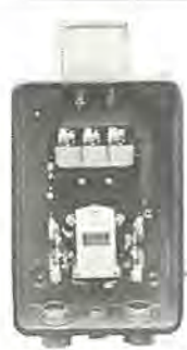
図 6-16 EKC-155-1 形 電磁開閉器内部 Interior view of type EKC- 155-1 magnetic switch.
