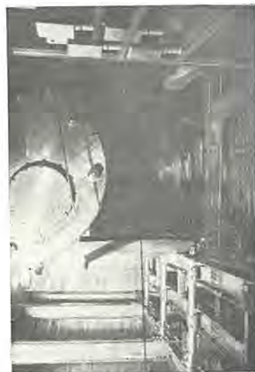
図 19-2 水中における使用済燃料 シャヘイ容器 および スラットコンベヤ Spent fuel transporting cask and slat conveyor underwater.
