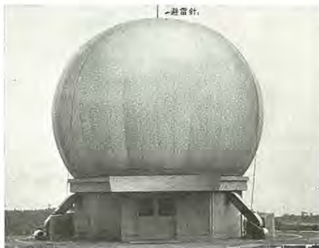
図 18-11 11.5mφ ソフトレドーム。 Soft Radome 11.5 m in diameter.
