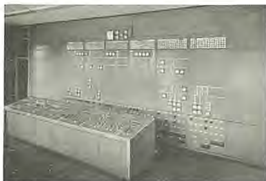
図 2-56 照光式模擬母線(北大阪) Illuminated mimic bus (Kita Ōsaka).
