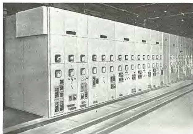
図 2-62 東京電力築地変電所納め 23 kV 1,500 A 配電用 キュービクル 制御盤側表面 23 kV 1,500 A distribution cubicle, as viewed from relay & meter panel side.
