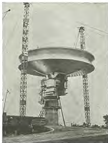
図 11-48 建設中のトラッキング テレメータ 空中線 (直径 18m) Construction work of 18 meters dia. tracking telemeter antenna for space probing.
