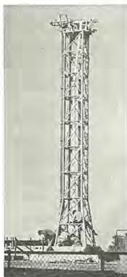
図 11-22 大口径空中線用 一次放射器 Back-net type mirror antennas primary radiator.
