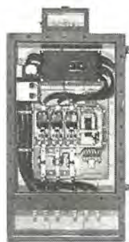
図 4-31 EDX-15A 形防爆 電磁開閉器 Type EDX-15A explosion proof combination line starter AC 600 V 300 A d2G4.
