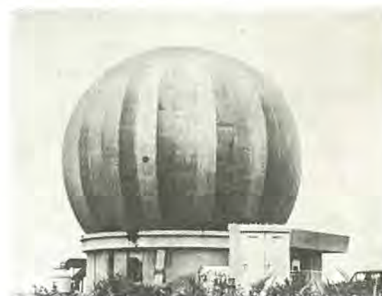
図 11-44 直径 11 m の レードーム 内に設置 された追尾装置 Communication satellite tracking device installed in a radome (diameter : 11 m).
