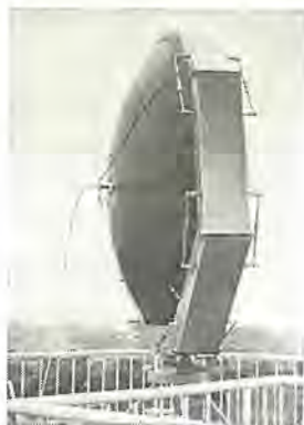
図 11-27 700 Mc 帯気球 アンテナ (1.7 mφ) 700 Mc band balloon antenna (1.7 mφ)
