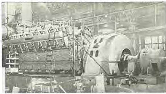
図 1-22 ラオス政府納め 1,250 kVA 交流発電機 1,250 kVA 6,600 V 50 c/s 12 P 500 rpm AC generator set for Laos.
