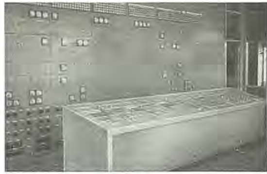
図 2-55 関西電力北大阪変電所納め照光式主配電盤 Illuminated main switch board
