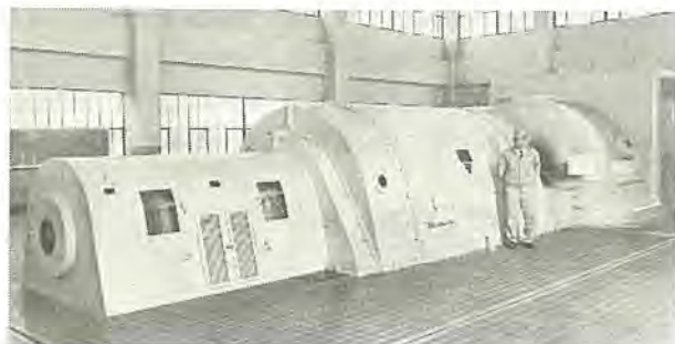
図 1-7 宇部セメント西工場納め 33,333 kVA 空気冷却 タービン発電機 33,333 kVA air-cooled turbine generator for Ube Cement.
