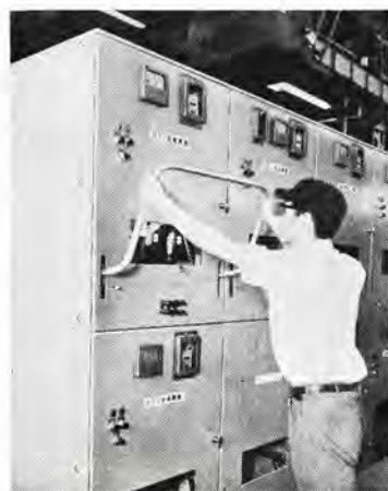
図 3.5 台車引出操作 Fig. 3.5 Drawing out of truck.
