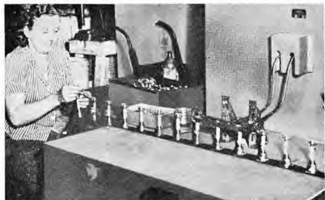
図 3.32 プッシュング用自動ロー付機械装置
