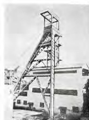
図 3.1 立坑やぐら全形 Fig. 3.1 Shaft tower.
