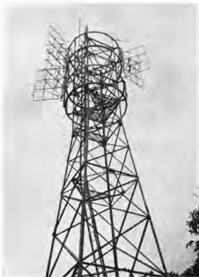
図 1.1 基地局の鉄塔に取り付けられた 400 Mc 帯高利得コーナリフレクタアンテナ
