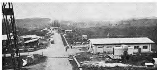
図 1 宇宙通信実験所構内の一部、向う正面は 6m 追尾アンテナ、右側の建物は中央管制室
