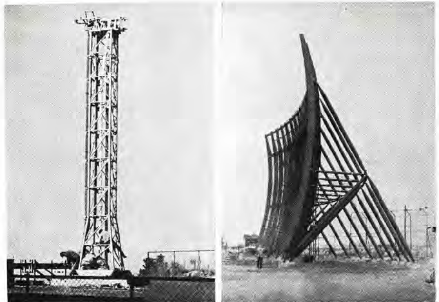
図 1.2 大口径アンテナの一次放射器と反射鏡
