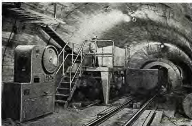
図 6.3 坑底操車線設備 チョウラ 前
