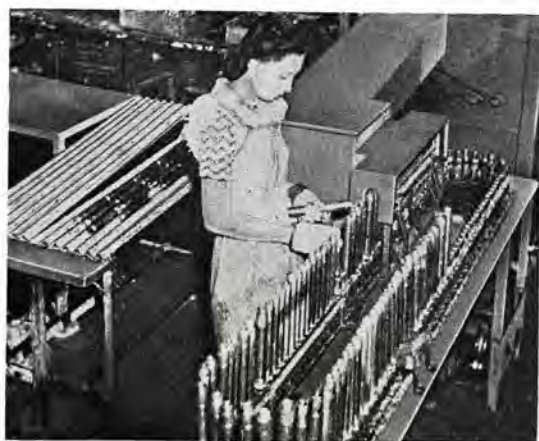
図 3.33 自動ロー付送り機械装置
