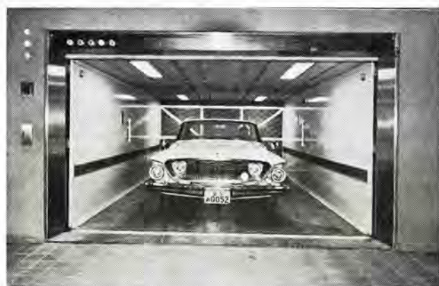
図 4.1 乗用車用エレベータ Fig. 4.1 Elevator for passenger cars.
