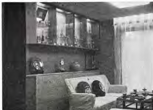
図 4.3 コーニスライトの例 Fig. 4.3 Example of cornice lighting.
