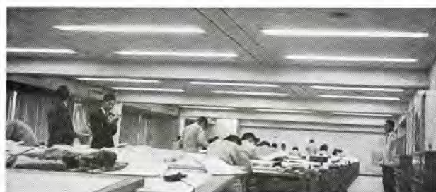
FLR-H×WDL×2 灯用埋込器具 45 セット 天井の高さ 2.75 m 床面積 422 m 2 平均照度 700 lx
