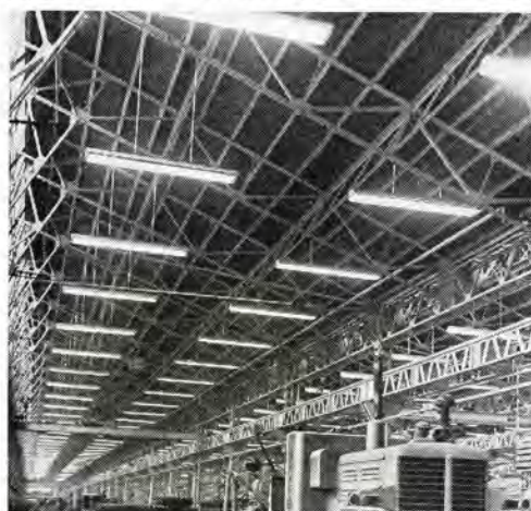
ランプ FLR-110 H×3 灯用 器具 光源高さ 7m 床面積 17,800 m 2 平均照明 350 lx
