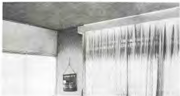
図 4.4 バランスライトの例 Fig. 4.4 Example of valance lighting.
