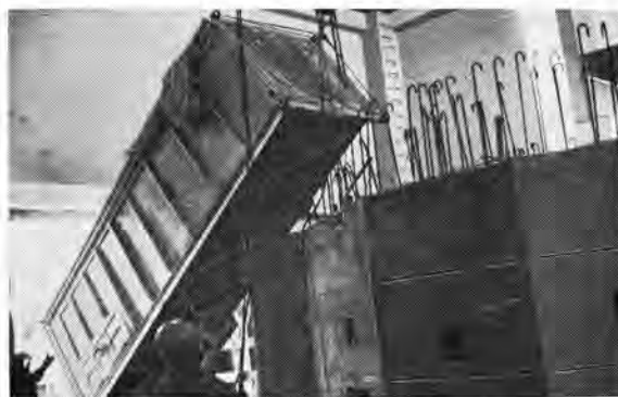
図 4.1 炉心タンクの据付作業 Fig 4.1 Installation of huge core tank.
