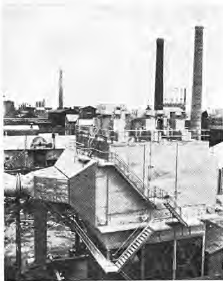
図 2.1 高圧電源装置の取付状況（第一セメント納め） Fig. 2.1 High voltage silicon rectifier power supplies mounted on the Cottrell electrostatic precipitator.
