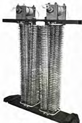
図 4.3 整流器 スタック 組立 Fig. 4.3 Rectifier stack assembly.
