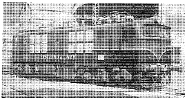
図 2 インド国鉄向け WAM 20310 形イグナイトロン式交流機関車
