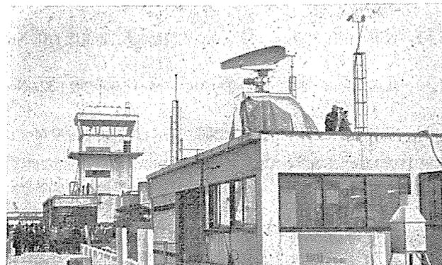
図 7.1 実用試験中の RH-3 形レーダ
