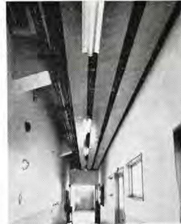
図 2-46 BF 形フェーダバスダクト 工事の一例 (三菱電機、商品研究所納め) An example of type BF feeder bus duct.
