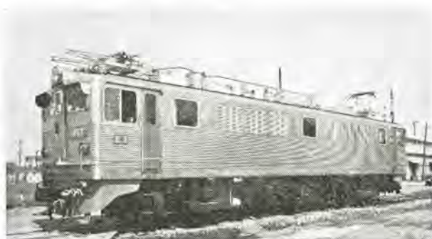
図 7-1 国鉄納め EF30 形交直両用機関車 Type EF30 AC-DC locomotive for the Japanese National Railways.
