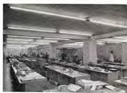
⑰ 飯野ビル 事務室 (東京) 高出力 FLR-110 H-W×1 灯 2 連 机上面平均照度 700~800 lx。
