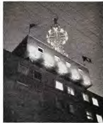
② 山形新聞ビル（山形） ビル屋上 の塔屋の照明で、H-400 T×5 灯を上向き投光器に使用し、投光器は壁面より突出したパイプの先端に取付けられている。
