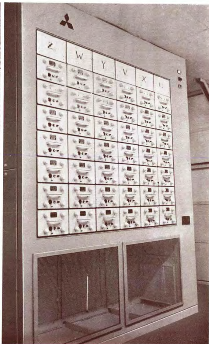
日本曹達二本木工場納め 5,290 kW 風冷式シリコン整流器(トレイ方式)
