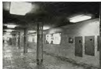
㉞ 東京都営地下鉄 蔵前駅 (東京) FY 形 埋込形下面アクリライトカバー 40 W 5 灯 および 40 W 3 灯、 床面平均照度 180~140 lx.
