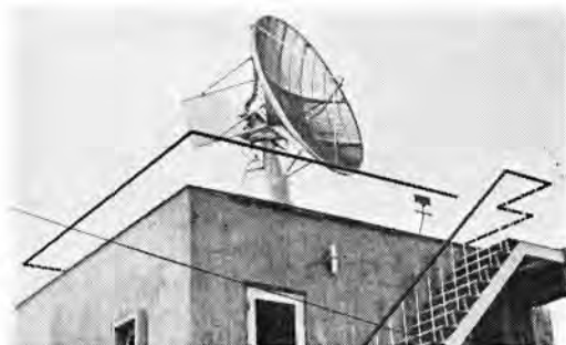
図 11-34 名古屋気象台に設置された空中線装置 (RC-4 形) Antenna assembly installed at Nagoya Meteorological Observatory. (type RC-4)
