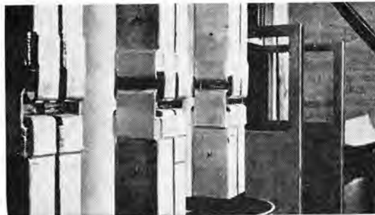
図 2-45 アルミニウム 積層 ジョイント の現地溶接 Field welded laminated connectors of alminum.
