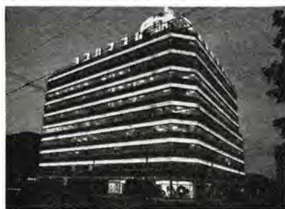
③ 横浜ゴムビル（東京） 建物壁面のガラス・ブロック の内部 FL-40×2 列に収めた壁面照明。
