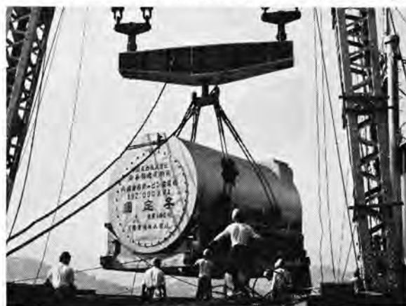
図 1-1 中国電力新宇部発電所納め 192,000 kVA 内部冷却タービン発電機 192,000 kVA inner cooled turbine generator for Chugoku Electric Power, Shin-Ube Power Station.
