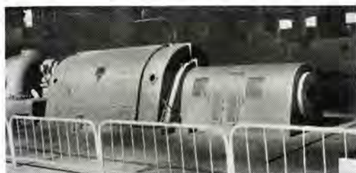
図 1-8 現地運転中のパキスタン Fenchuganj 納め 15,000 kVA タービン発電機 15,000 kVA Turbine generator now in operation at Fenchuganj, Pakistan.
