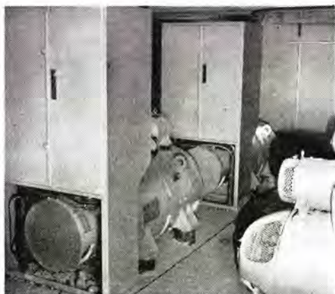
図 9-8 436RS 形電動発電機 Type 436RS motor-generator set.
