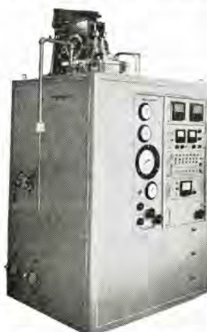
図 19-25 ヘリウム液化装置 Helium liquefier.
