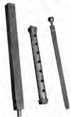
図 18-2 制御棒および案内管 Control rod and guide tubes.
