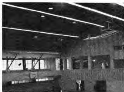
⑨ 三菱電機 神戸体育館（神戸） デラックスケイ光水銀ランプ HF-400-SDT×24 灯と高出力ケイ光灯 FLR-60 H×396 灯、室 面積 1,036 m 2 (33 m×31.4 m) でアーチ天 井最高部 11 m、演色性をとくに考慮した 照明である。
