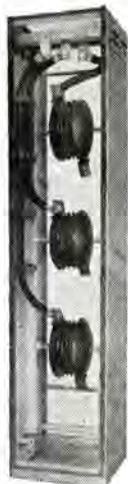
図 2-21 MSP 形 限流リアクトル・コントロールセンタ 取付 Type MSP current limiting reactor mounted on control center.
