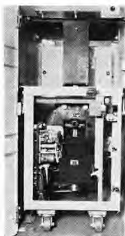
図 2-41 ER 形キュービクルに納まった DR 形シタ断器 Type DR circuit breaker housed in type ER cubicle.
