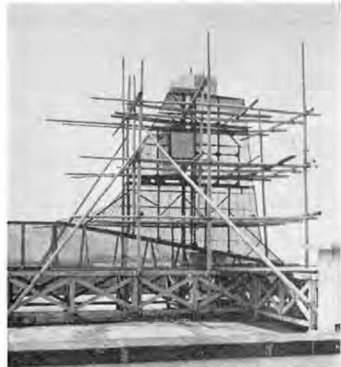
図 2.2 インピーダンス特性測定用中形輸送機 YS-11 後部擬似実物大模型
