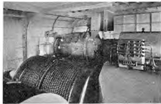
図 3.1 開閉電動機据付状況
