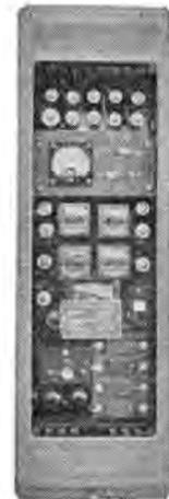
図 2.3 KVG-M 形 1 線地絡検出継電器
