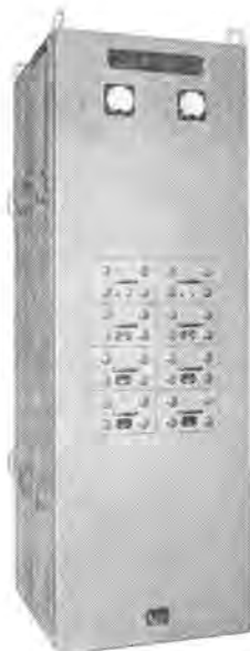
図 5.5 150 kW レクチフロードライブ用シリコン整流器盤 (強制風冷) Fig. 5.5 Silicon rectifier for 150 kW RECTIFLOW DRIVE (Fan cooled DC 440 V 185 A).
