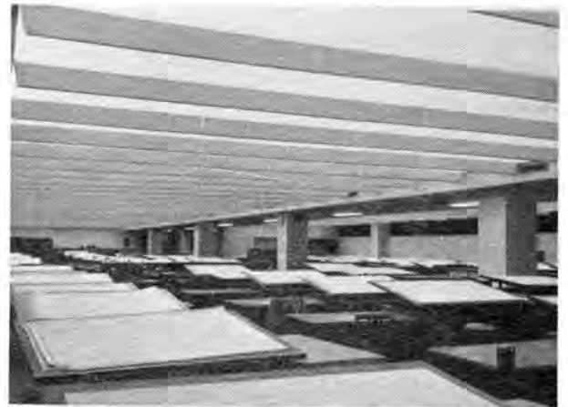
図 2.1 設計室の光り天井照明 (夜間 A 2 , C 面) Fig. 2.1 Luminous ceiling of drafting room.
