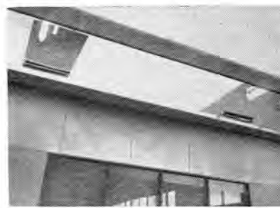
図 7.8 光り天井内部通風口を示す Fig. 7.8 Cavity.
