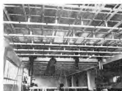
図 7.5 アクリライトパネル支持ワックおよび吸音バツフルを取付ける Fig. 7.5 Acrylite panel frame and acoustic baffle.
