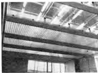
図 7.7 アクリライトパネルを敷きならべる Fig. 7.7 Acrylite panels are board.
