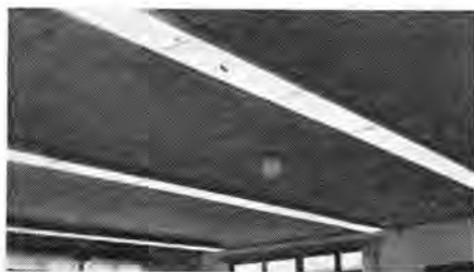
図 6.1 ルーバ灯具でトロファ照明した製図室 Fig. 6.1 Troffer.
