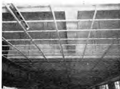
図 7.3 スラブからのインサートボルトで取付用チャンネルをつくる Fig. 7.3 Mounting channels suspended by insert bolts from slabs.
