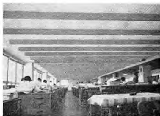
図 4.1 光り天井照明の設計室（昼間 H 1 B 面） Fig. 4.1 Drafting room with luminous ceiling.
