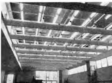
図 7.6 器具の取付け終わる Fig. 7.6 Completing the fitting of luminaire.
