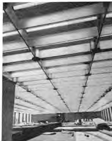
図 6.2 ルーバロール照明の設計室 (ゼネラルモータース) Fig. 6.2 Louverall ceiling drafting room, general motors office building.
