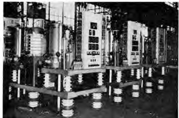
図 4.19 50 kVA 高電圧イグナイトロン整流器
