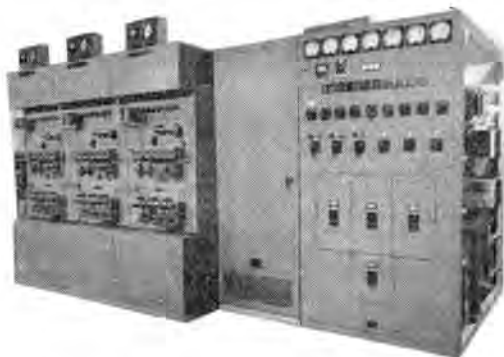
図 4.9 45 kVA 50 c/s 三相を 60 c/s 単相に変換する周波数変換器の外観
