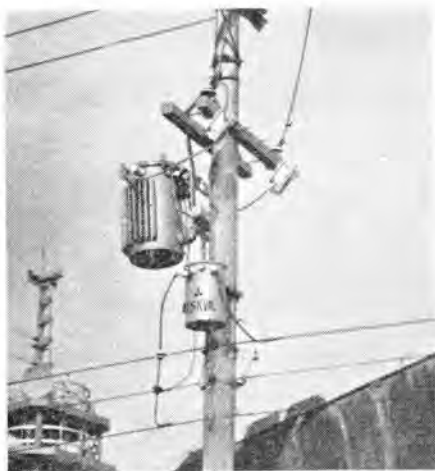
図 3.1 ポールレグ装柱図 Fig. 3.1 Trial installation of POLEREG with 30 kVA transformer.
