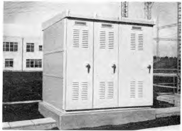
図 6.4 所内電源キュービクル Fig. 6.4 Station service power source cubicle.
