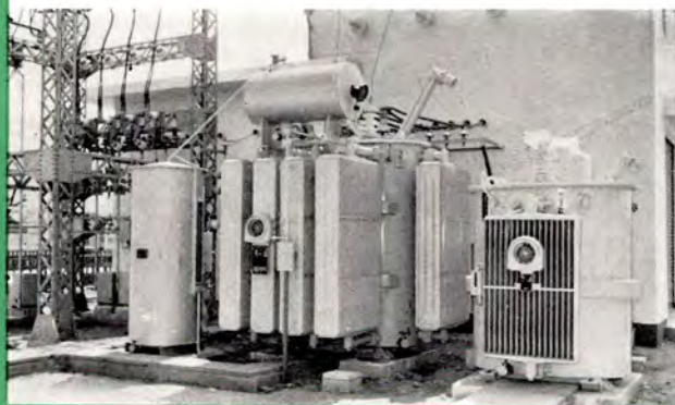
◀ 主変圧器 三相屋外用超D種定格、 油入自冷式 電圧 22,000 1,170 V 容量 3,300 kVA, 60 c/s (右側は 直流リアクトル)
