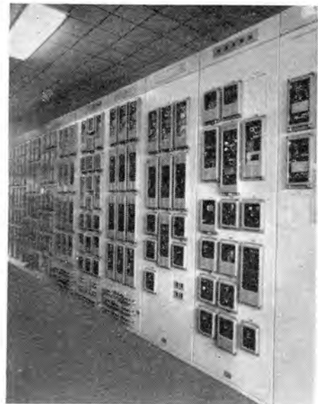
図 6.5 継電器盤 Fig. 6.5 Relay panel.
