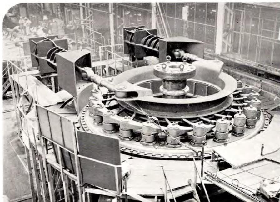
カプラン水車としてわが国最大で出力 50,100 kW 立テ軸単輪単流水車が新三菱重工業神戸造船所で完成した。水車ランナは7枚羽根で有効落差 37.3 m、流量 150 m<sup>3</sup>/s、回転数 150 rpm である。
