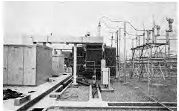
充填絶縁内部冷却変圧器
