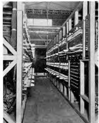
図 3.4 模擬送電線スイッチ盤
