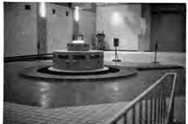
図 2.1 80,000 kVA カサ形 水車発電機
