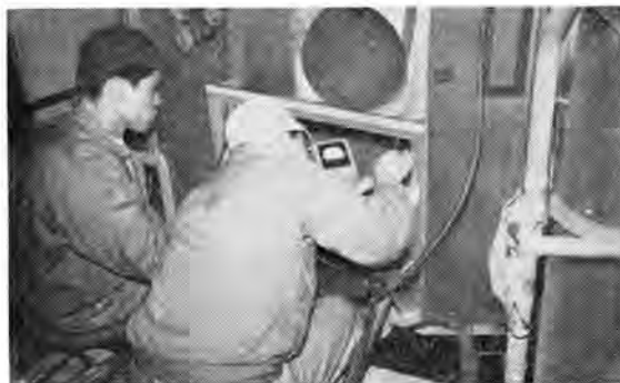
図 6.5 重水タンクのもれ試験(積分法) Fig. 6.5 Helium leak test of D_2O tank. (by Integral Method)
