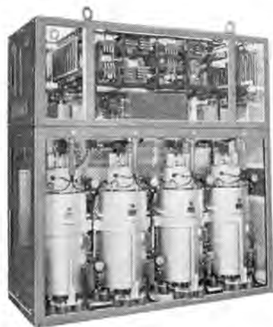
図 4.2 イグナイトロン整流器 Fig. 4.2 Ignitron rectifier.
