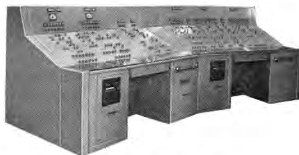
図 2.2 門司港制御所継電器盤 Fig. 2.2 Mojiko c/c control desk.
