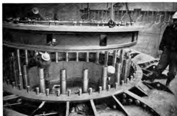
図 3.4 現地組立中の本体 Fig. 3.4 Water wheel under assembling.
