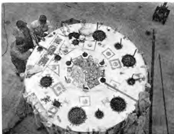
図 3.5 下部プラグコンクリート打設 Fig. 3.5 Concrete pouring to lower plug by prepacked method.
