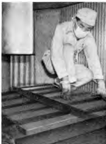
図 3.7 サーマルコラムグラファイト積込み Fig. 3.7 Mounting of graphite in thermal column.
