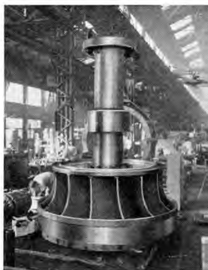
図 3.5 主軸と連結された製作中のランナ Fig. 3.5 Runner connected with a shaft.
