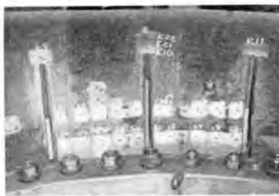
(b) 補強リウ 溶接後のヒズミ計 取付状態
