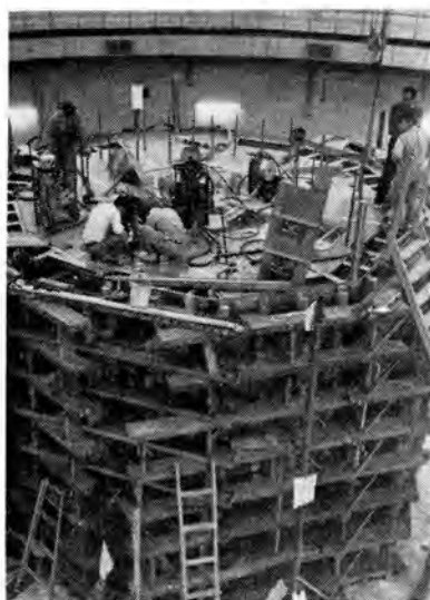
図 3.6 炉体シヤハイコンクリート打設 Fig. 3.6 Concrete grouting.
