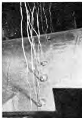
(e) 外部ヒズミ計 取付状態
