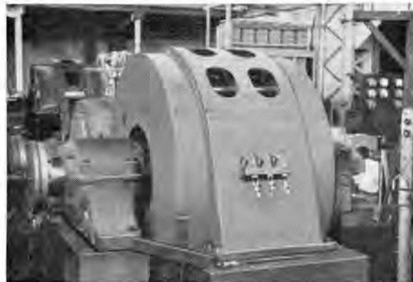
図 1-22 電電公社東京総合局納め、ディーゼル 交流発電機 2,000 kVA 3,300 V 50 c/s 12 P 500 rpm 0.8 PF 自動式 SFS 開放形
