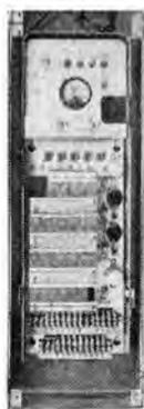
図 9-2 関西電力本社ビル 光電装置制御盤 Photoelectric control panel.
