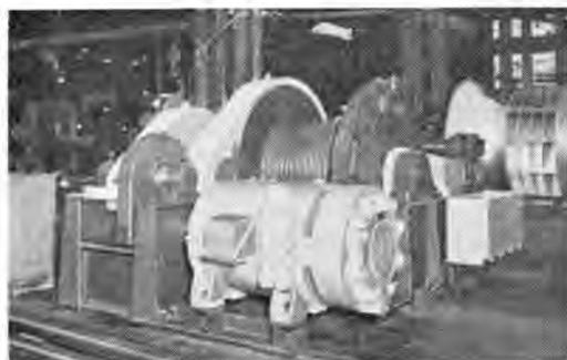
図 6-17 トゥイングウインチ用直流電動機 45kW 220V 380rpm 他励全閉水密管通風形連続定格 DC motor for towing winch.
