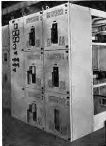
図 2-54 閉鎖三段式パワーセンタ
