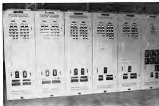
図 4-10 磁気増幅器盤
