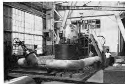
図 17-4 350 kVA キャンドモータポンプ用高温高压テストループ
