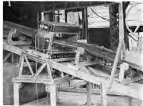
図 12-21 検出コイル架据付けの実相
