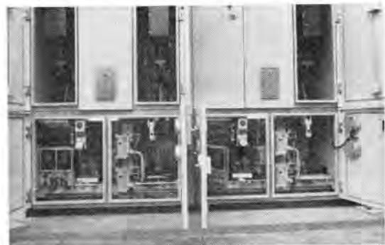
図 2-35 同時投入防止装置付 20-C-100 形空気シ断器
