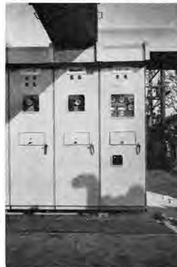
図 2-53 梅島変電所納め配電用キュービクル
