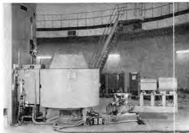
図 17-22 原研向け中性子スペクトロメータを JRR-2 原子炉に据付けたところ
