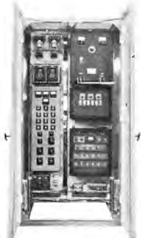
図 3-11 (a) 定電流制御盤負荷時電圧調整器制御回路部
