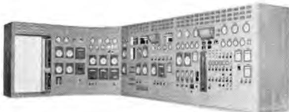
図 1-16 九州電力新港発電所納め 中央監視制御盤
