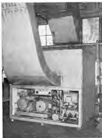
図 10-5 PH-4W-F 15kW ヒートポンプ式パッケージ形冷房機 Type PH-4W-F 15kW heat pump type packaged air conditioner.
