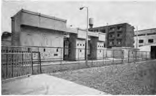
図 2-51 ソニー株式会社 納め屋外用相隔壁形 23 kV 600 A 1,000 MVA キュービクル開閉装置
