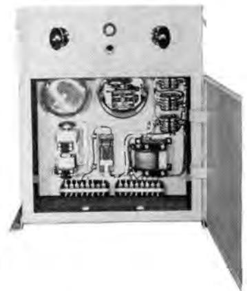
図 5-19 ポンプ自動運転用低圧側接触器盤
