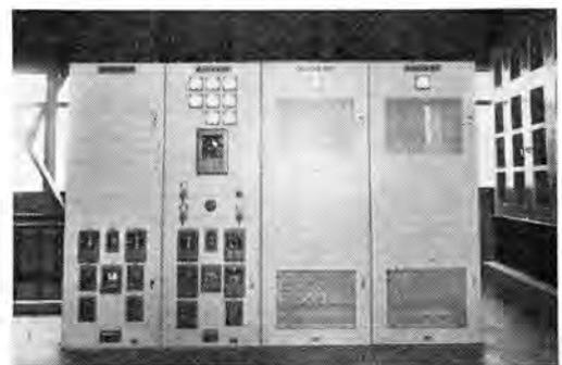
図 1-21 九州電力新港発電所納め、自動電圧調整器盤
