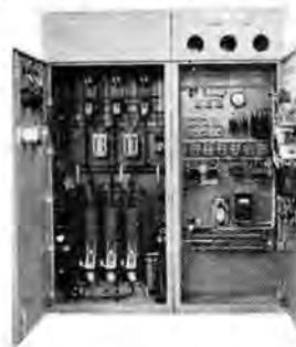
図 4-122 (左側) LSH 形交流気中配電箱 (断路器付)
