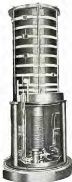
図 3.3 鉄心絶縁変圧器
