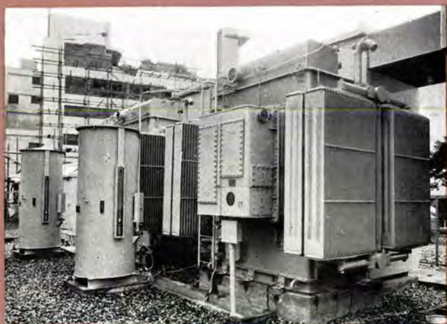
2,000 kVA 三相油入変圧器（負荷時タツウ切換器付）
