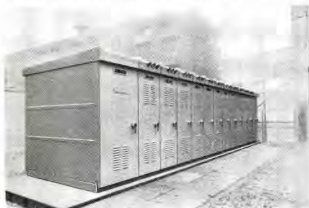
図 4.1 3 kV 屋外 メタルクラッド
