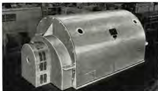
10,000 kVA 自励タービン 発電機
