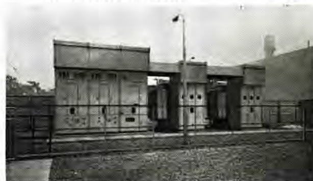
図 3.1 20 kV 屋外 キュービクル 外観 Fig. 3.1 Exterior view of 20 kV outdoor cubicle.
