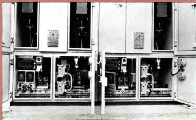
20-C-100形 空気シヤ断器内部
