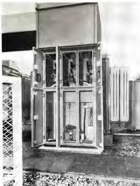
図 3.5 LC-B 形負荷断路器
