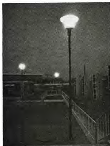
図 2.6(a) 東京都体育館の外灯照明 (ランプは HF-300 DT) Fig. 2.6(a) Outdoor lighting of Tokyo gymnasium.
