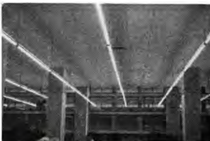
図 7.24 事務所建築などで近頃多く見られる照明手法。ケイ光ランプだけを宙づりして安定器は別の個所に置き、いわば光る棒を室内にかけ渡した照明である。広義に見ればこれも建築化照明の一種といえよう。写真は高天井の業務室に 110 W 高出力 ケイ光 ランプを長くつり下げ連続としたもの。朝日新聞東京本社
