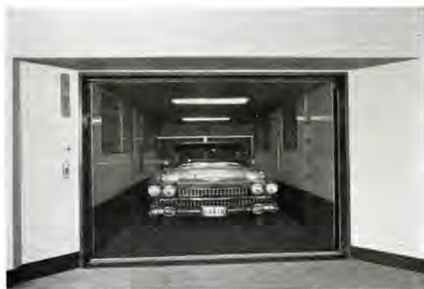
図 1.1 自動車用エレベータ Fig. 1.1 Garage elevators.
