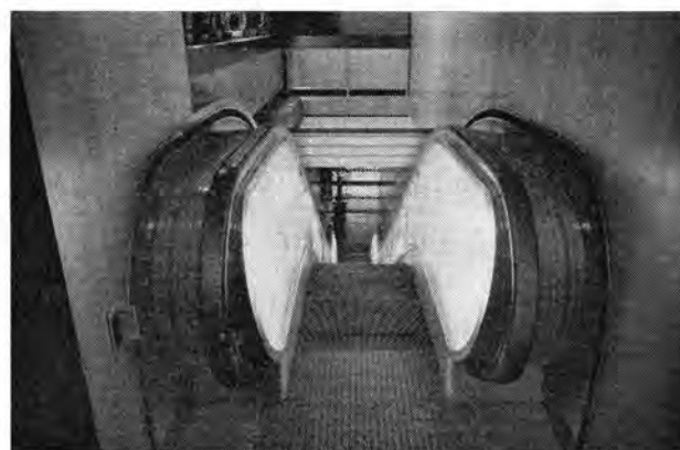
図 5.4 エスカレータ 防火 シャッターが閉り始めたところ Fig. 5.4 Escalator (Fire shutter began to close)
