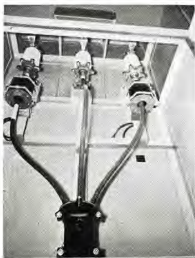
図 3.8 受電ケーブルキュービクルの内部 Fig. 3.8 Interior of receiving cable cubicle.
