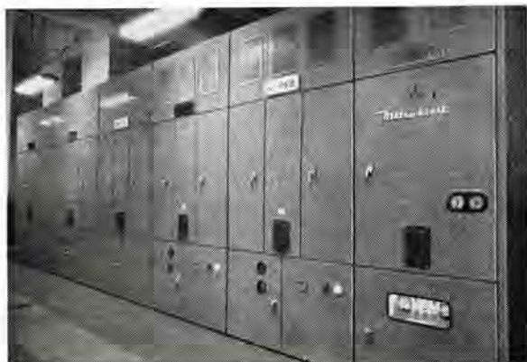
図 1.1 ビル用 20 kV キュービクル 外観 Fig. 1.1 Appearance of 20kV cubicle for building use.
