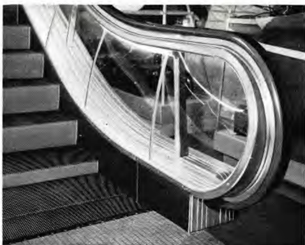
図 4.4 DTT 形エスカレータ 下部乗場 Fig. 4.4 DTT escalator lower landing.
