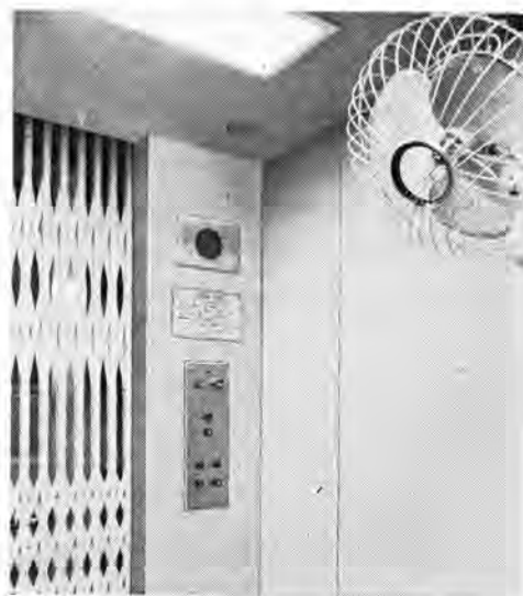
図 3.16 西 1 号機のカゴ（正）操作盤 Fig. 3.16 Car operating station of west machine No. 1.
