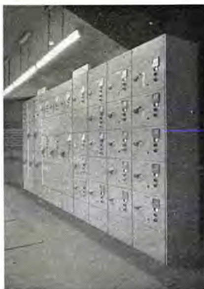
図 3.5 塔屋 コントロールセンタ Fig. 3.5 Type NC-2300 B control centers for the machine room at the roof.
