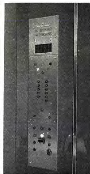
図 3.13 中央 1~4 号機のカゴ操作盤 Fig. 3.13 Car operating station.
