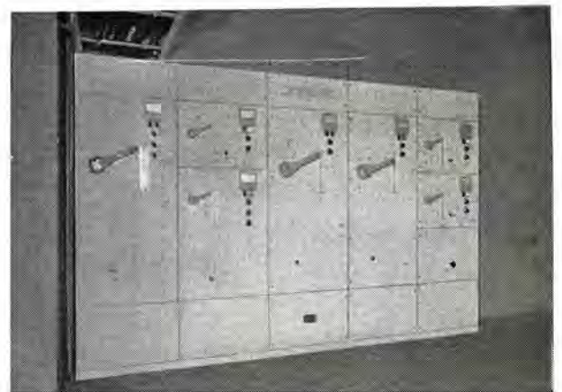
図 3.6 揚水ポンプコントロールセンタ Fig. 3.6 Type NC-1600 B control centers for water pumps.
