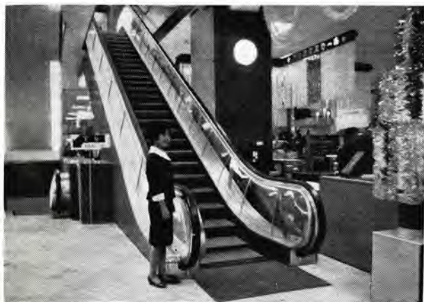
図 4.2 三菱 1200 DTT 形 エスカレータ、交差配置 Fig. 4.2 Mitsubishi type 1200 DTT escalator, criss-cross arrangement.
