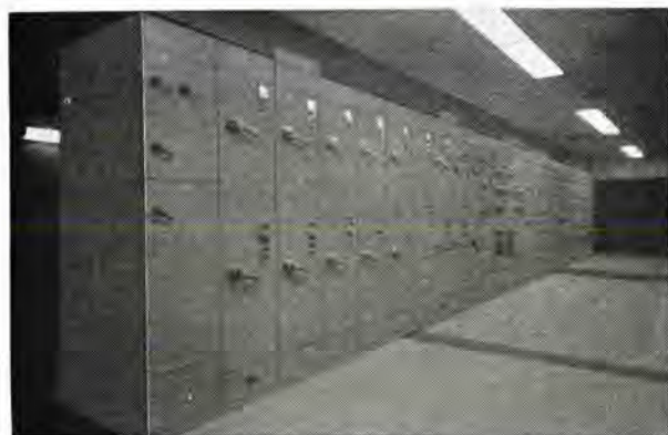
図 3.1 地下 2 階電気室設置 コントロールセンタ (正面側) Fig. 3.1 Type NC-2300 B control centers on the second floor of the underground substation. (front side)
