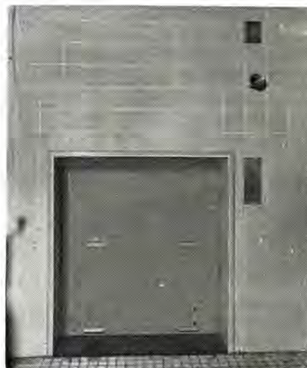
図 3.17 ダムウェータの出し入れ口
