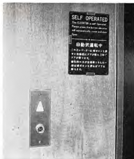
図 3.9 乗場ボタン切換スイッチ中央1,2号機1階
