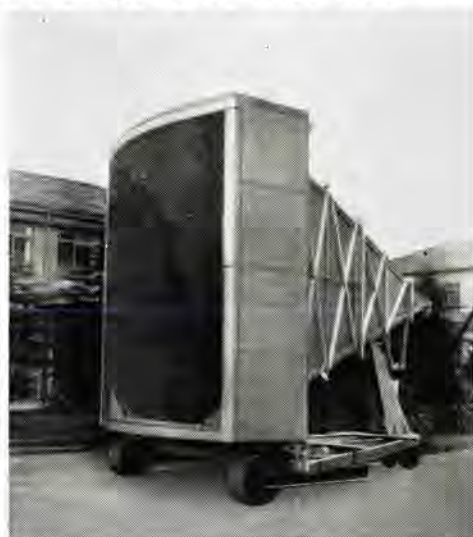
図 2.1 日本電信電話公社納入 4,000 Mc パスレングス レンズアンテナの前面板
