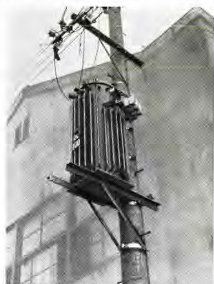
図 1.1 三相 100 kVA 巻鉄心形柱上変圧器 (過負荷保護装置付)
