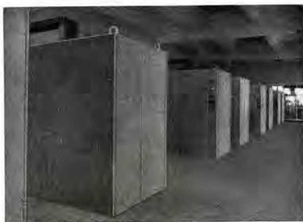
図 2.8 82V 120kA 風冷式 シリコン 整流器 Fig. 2.8 82V 120kA air cooled silicon rectifier.
