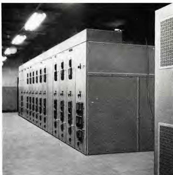
図 11.6 3 kV メタルクラッド
