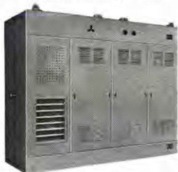
230 V 6,500 A シリコン 整流器外観 (左端は ネオンランプ 故障表示盤)
