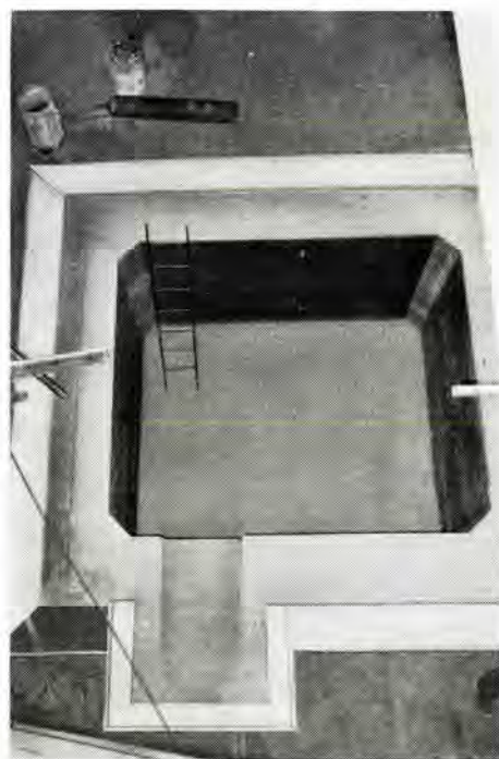
図 5.3 メッキ槽内張り Fig. 5.3 Lining of galvanizing pot.
