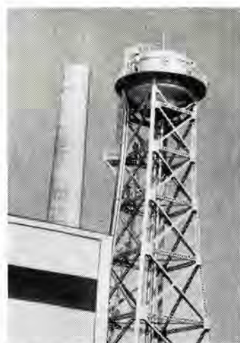
図 13.2 緊急用高架水槽と空気排気系の煙突
